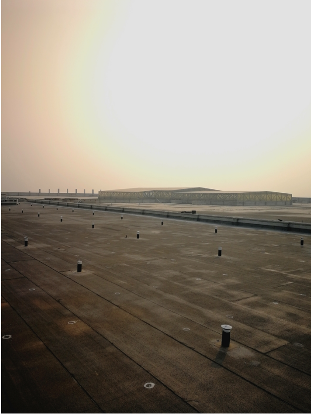
支架基础坐标点放线完成
