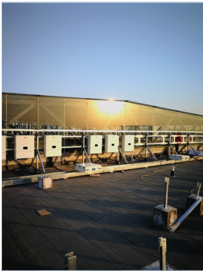
4 区逆变器安装
