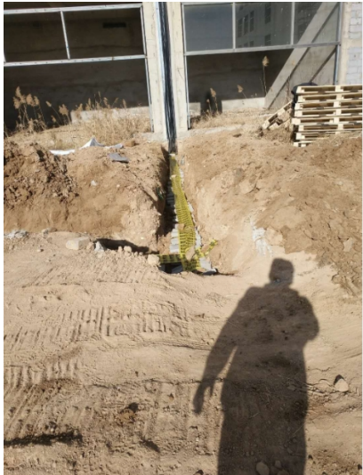
电缆盖砖回填
