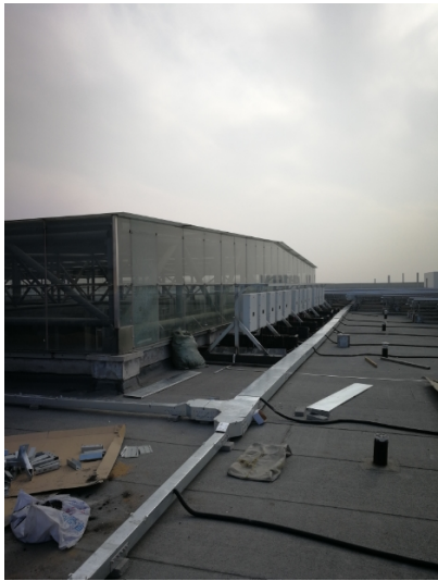
桥架槽盒盖盖板
