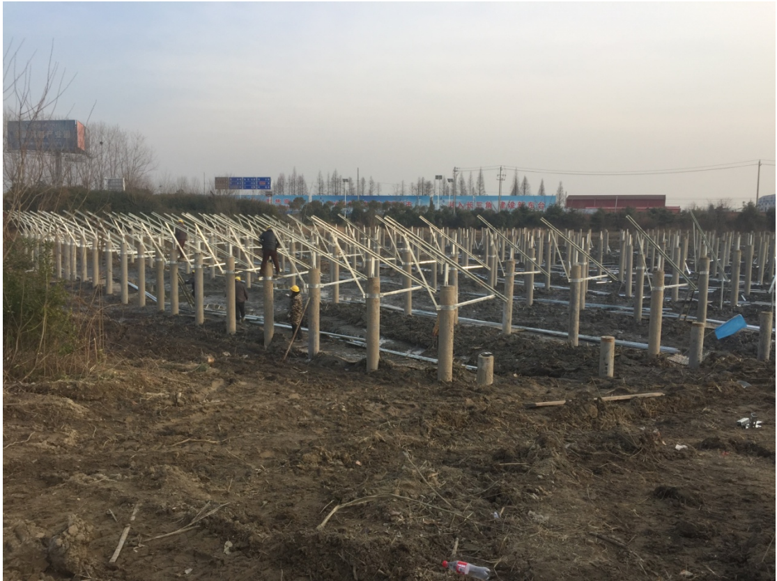
南沈灶支架安装
