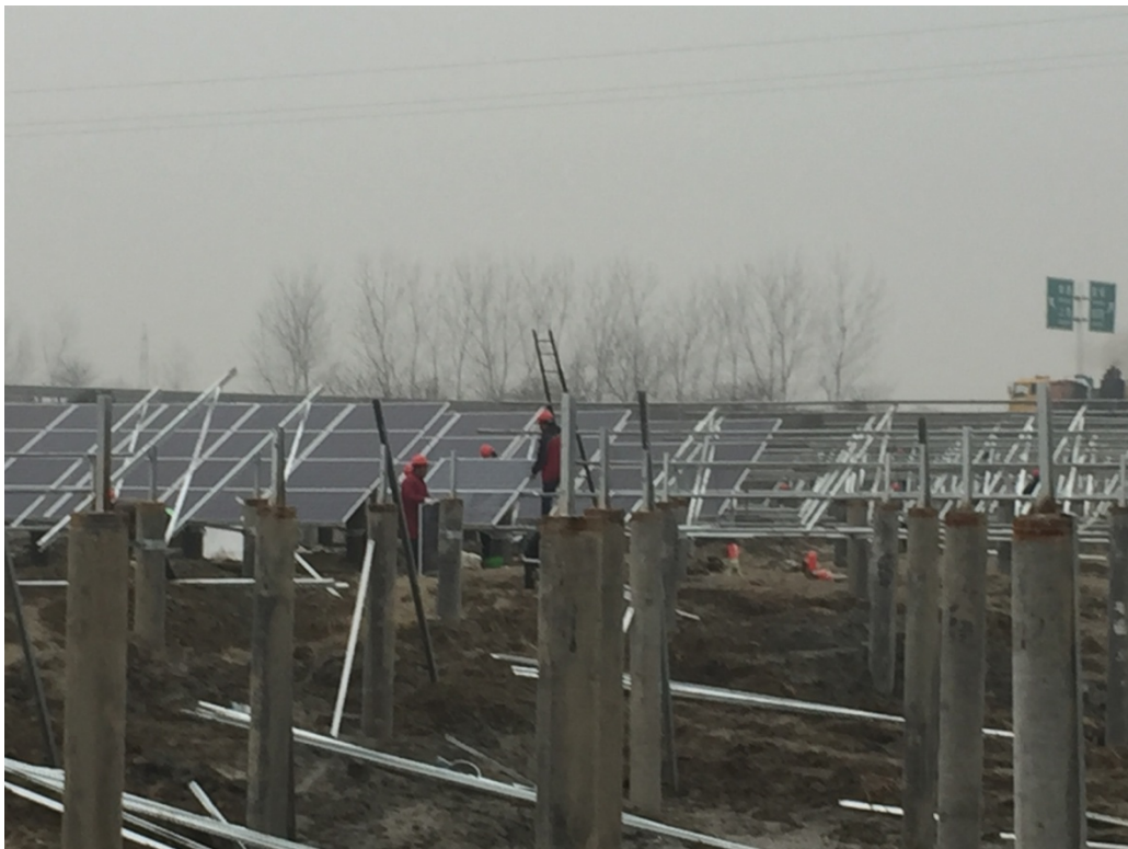
南沈灶组件安装
