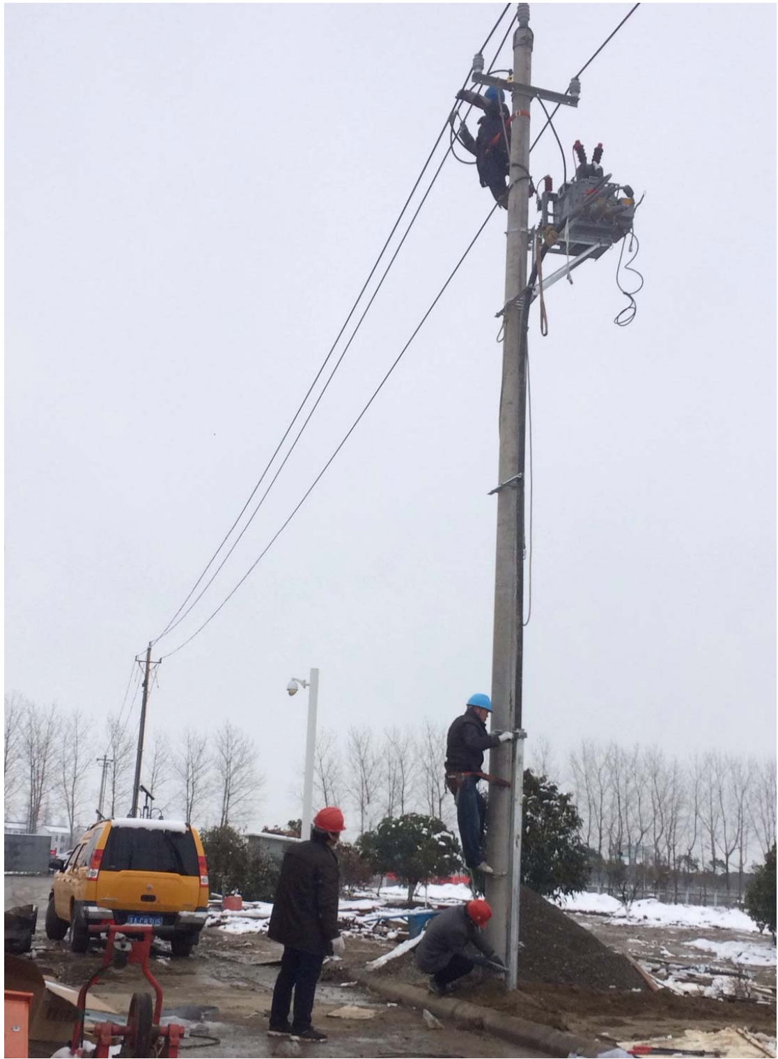
外电线路施工
