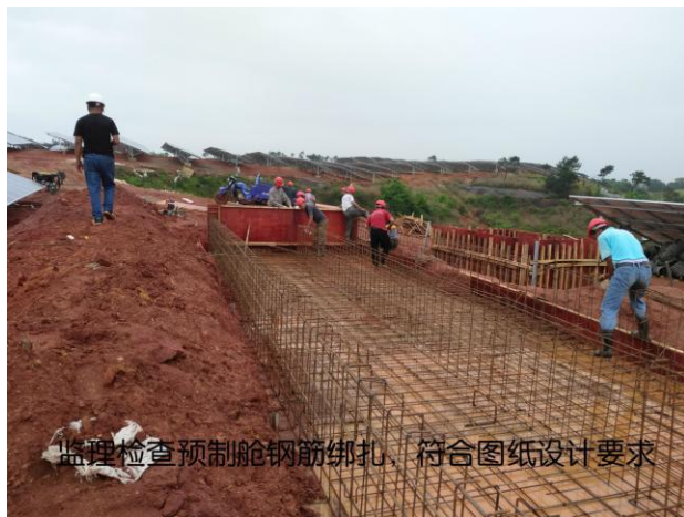
预制舱基础浇筑
