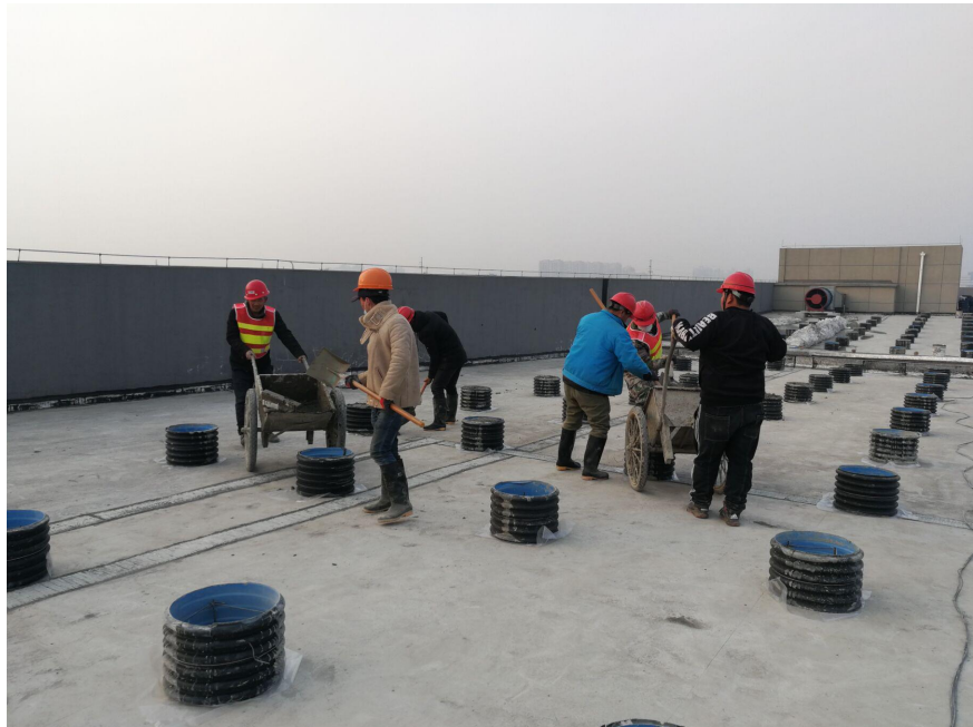
混凝土浇筑中
