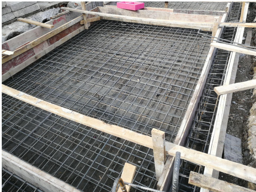
基础钢筋绑扎完成
