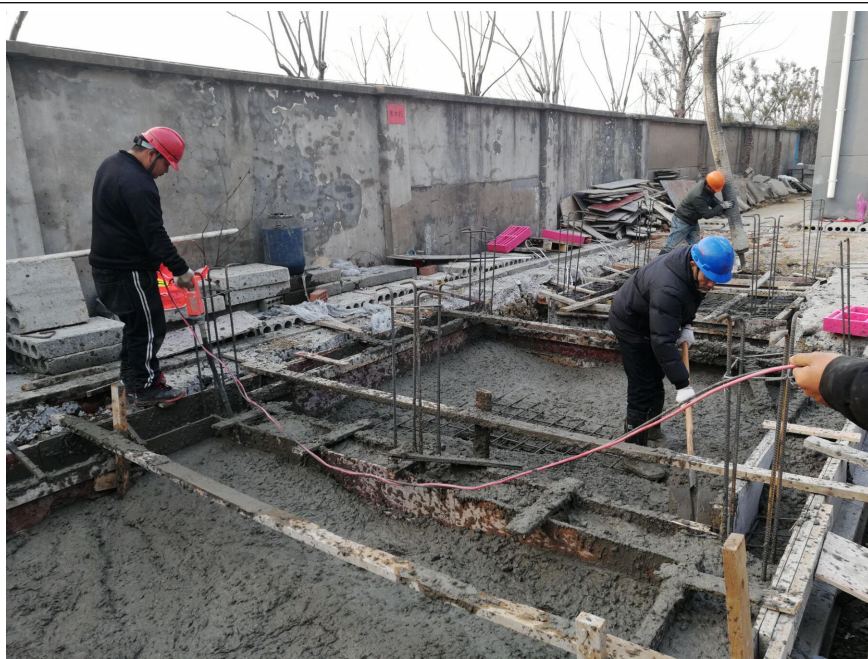
设备基础浇筑中
