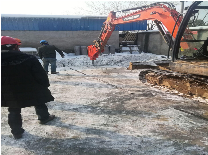
设备基础开挖中
