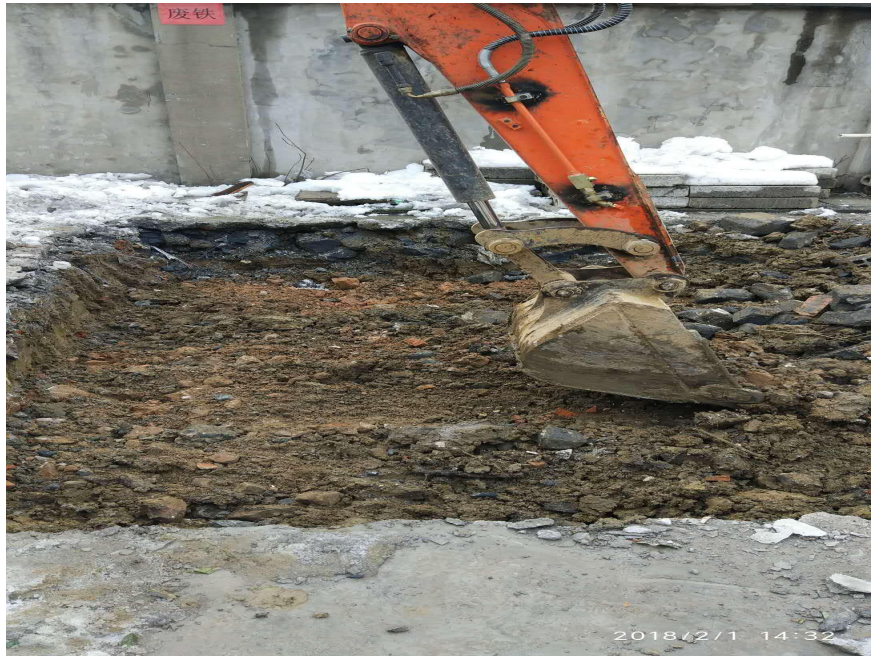
设备基础开挖中
