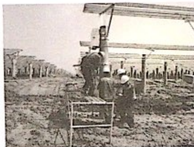
快庄桥架安装
