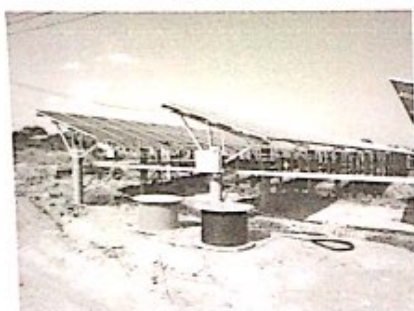
快庄光伏电缆敷设
