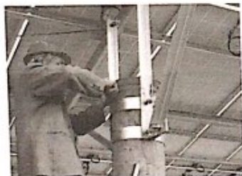
快庄桩头除锈，刷防锈漆
