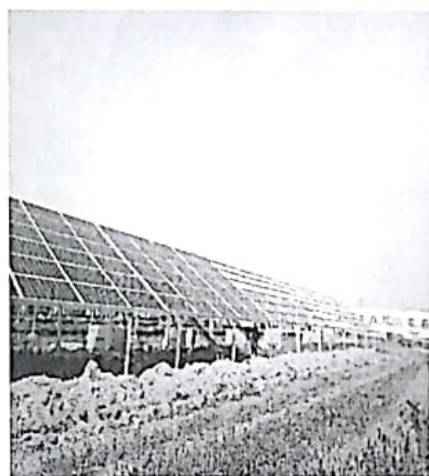
光伏区支架安装
