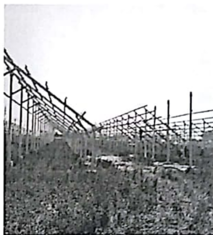
光伏区组件安装
