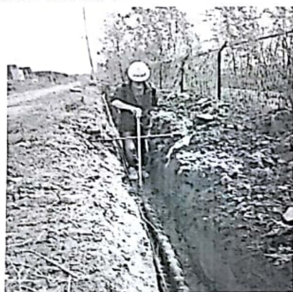
光伏区高压电缆敷设
