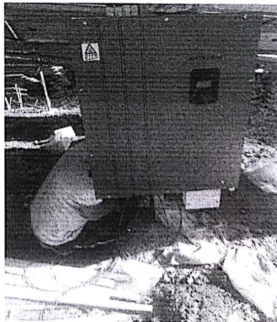
逆变器安装接线
