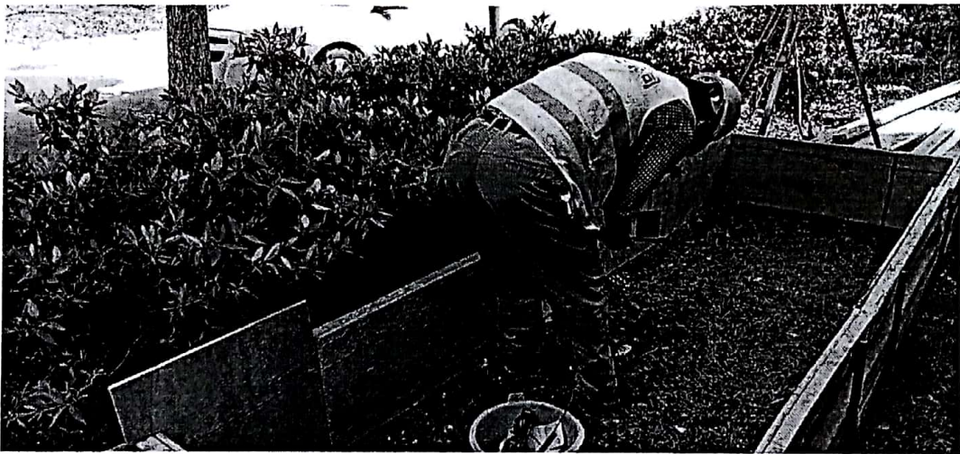
201 车间空调外机基础
