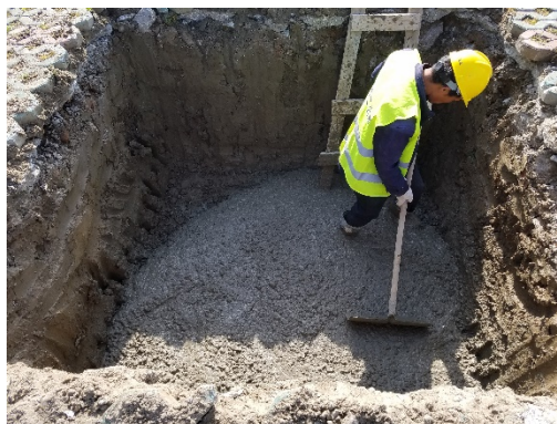
新建停车场车棚基础垫层浇筑
