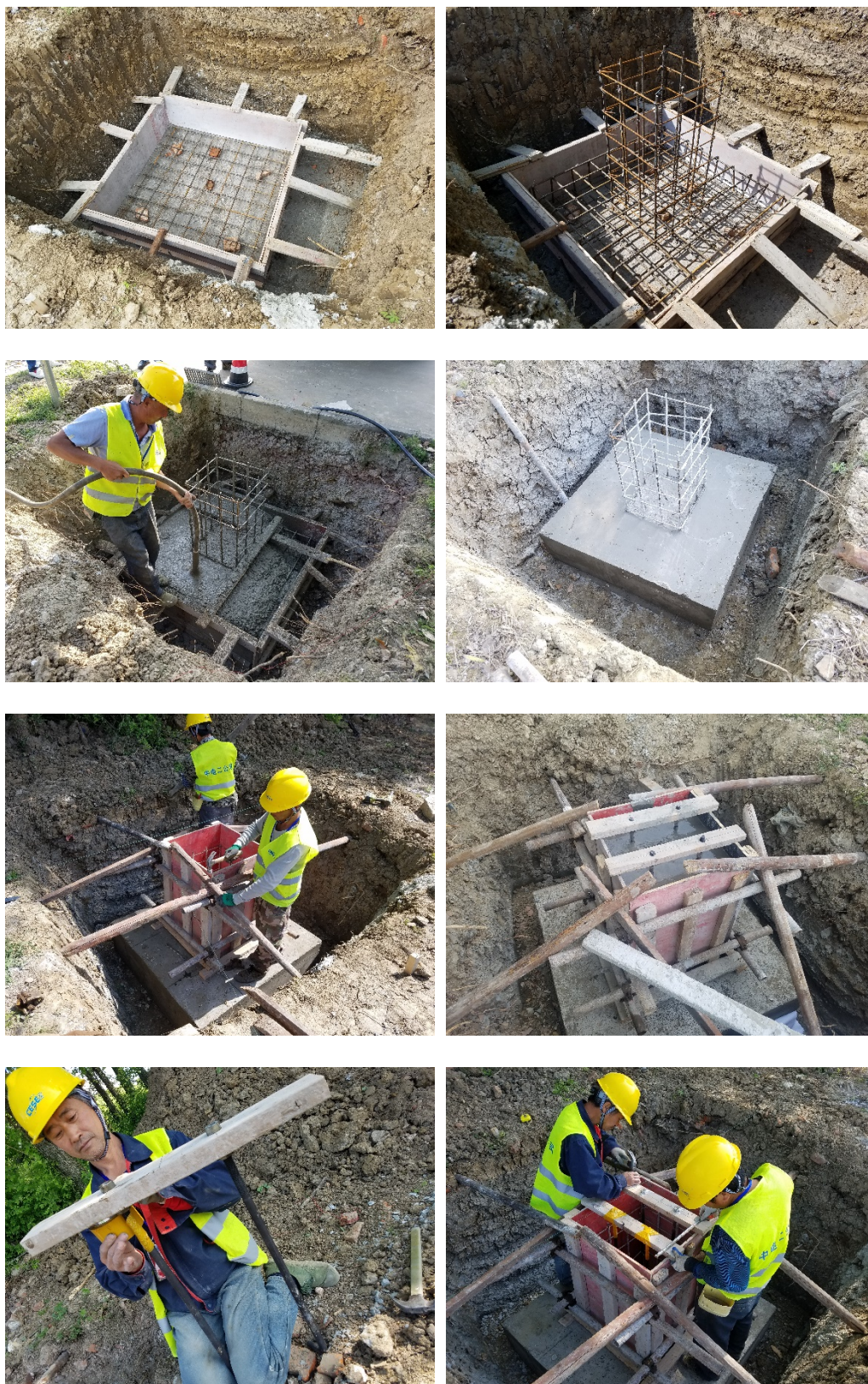
新建停车场车棚基础浇筑
