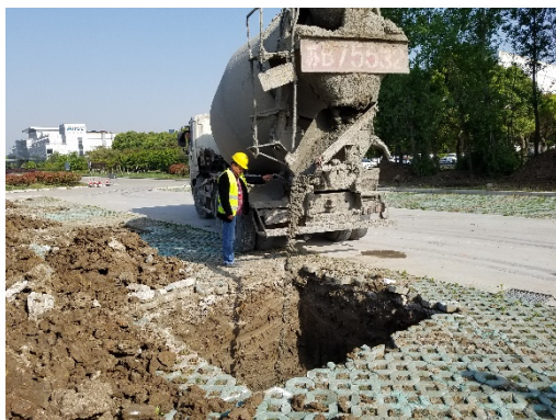
新建停车场车棚基础垫层浇筑
