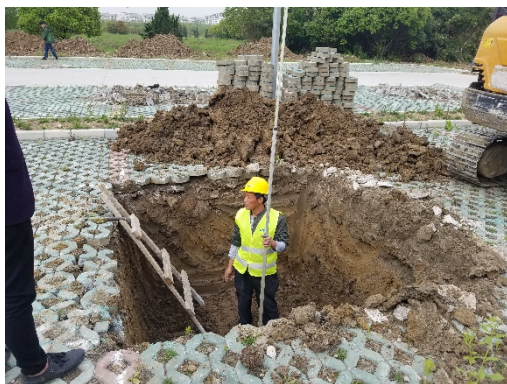
新建停车场车棚基础基坑检查
