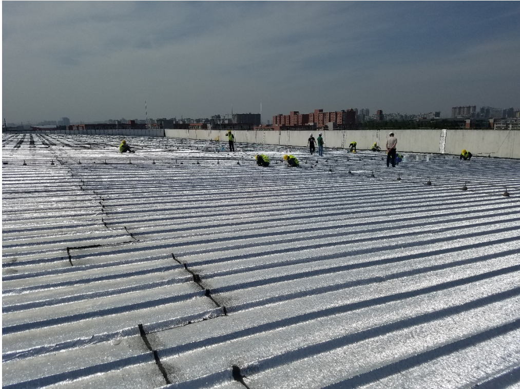
屋面防水层施工工序示意
