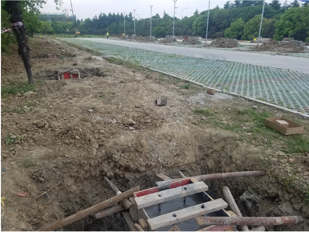
新建停车场车棚整体施工情况
