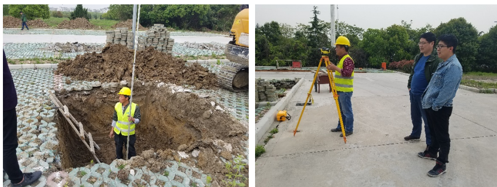
新建停车场车棚基础基坑检查
