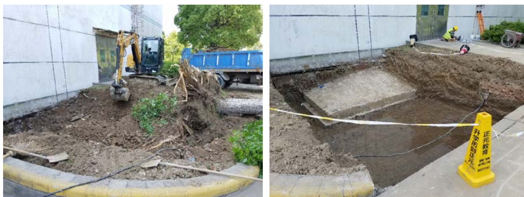
201 车间外墙上屋爬梯基础基坑施工情况
