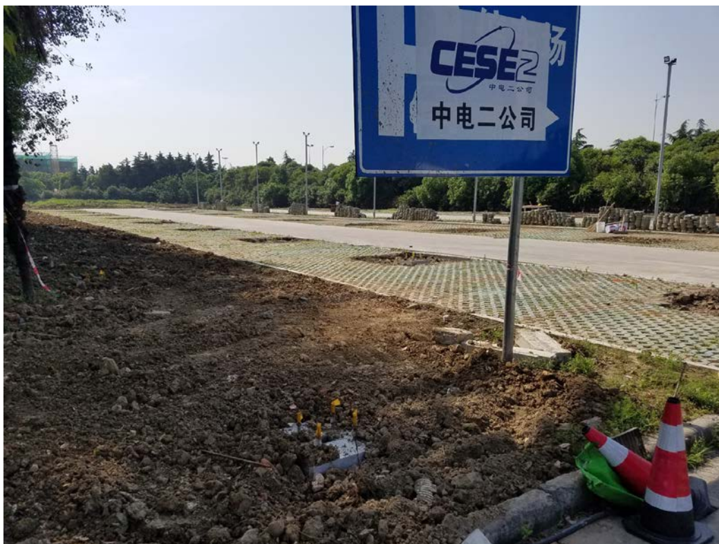
新建停车场车棚整体施工情况
