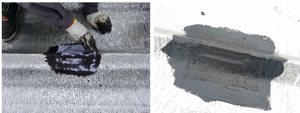
屋面防水层施工工序示意
