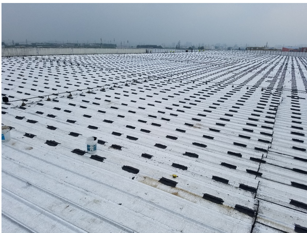
201 车间屋面夹具基础整体施工情况
