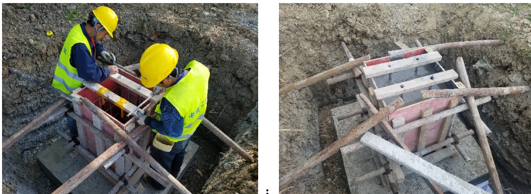
新建停车场车棚基础浇筑工序示意
