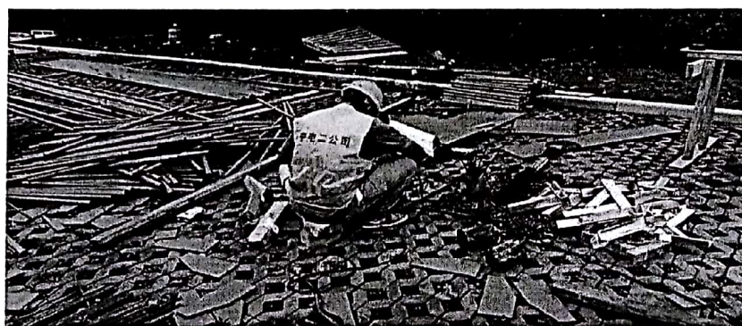
钢爬梯基础支模及浇筑
