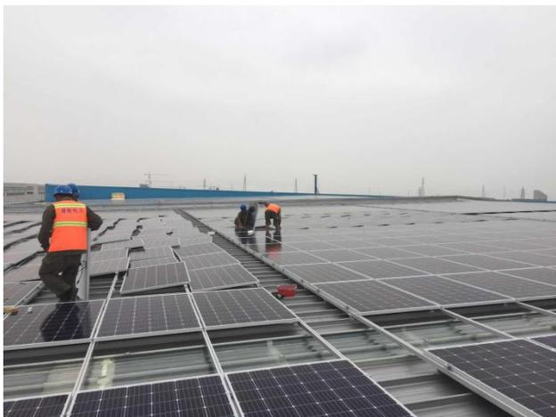
缆桥架安装完成，3#厂房屋面逆变器及电缆桥架安装完成完成；
