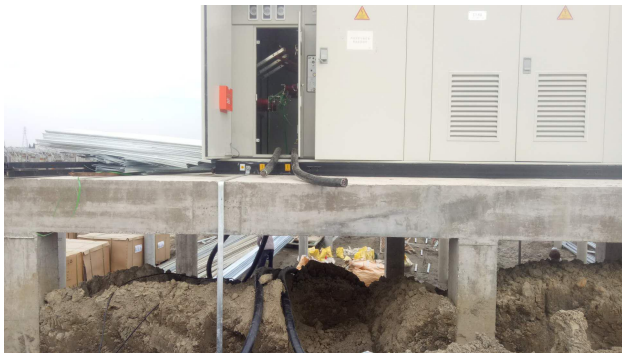
高压电缆头制作安装
