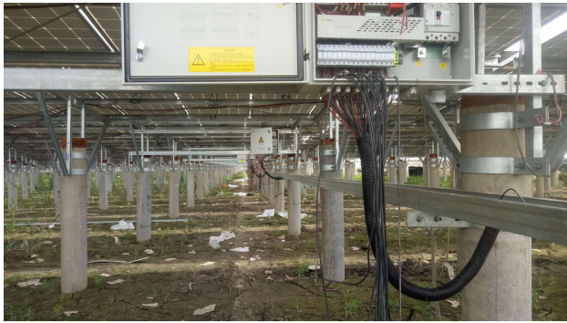
光伏区汇流箱安装完成
