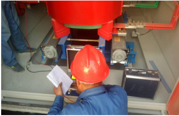
高压电缆耐压试验
