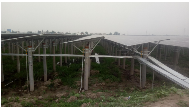
电缆桥架盖板安装完成
