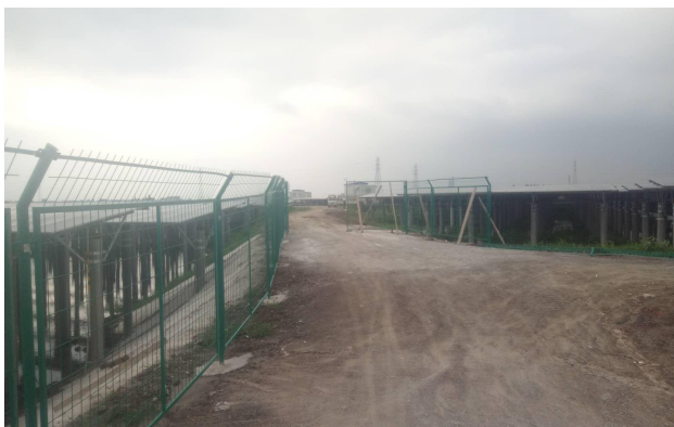
安全围网安装完成
