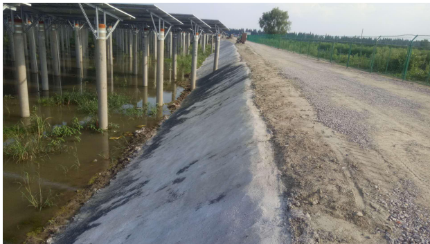
护坡施工完成
