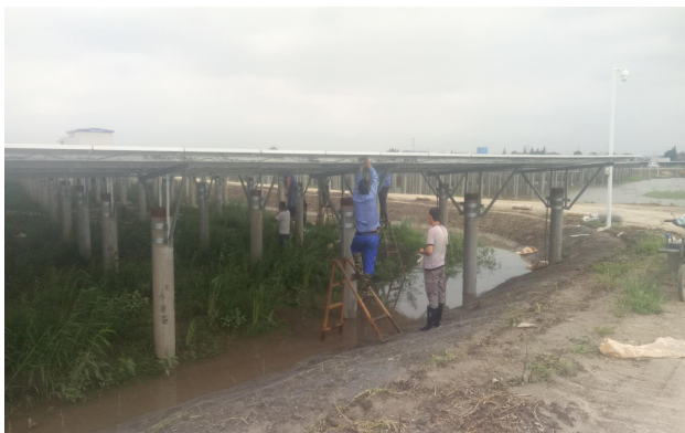
组件接地线安装
