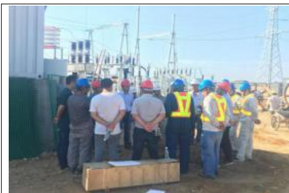
升压站倒送电启动委员会
