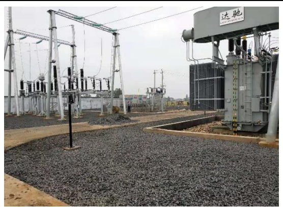
升压站设备区铺设碎石
