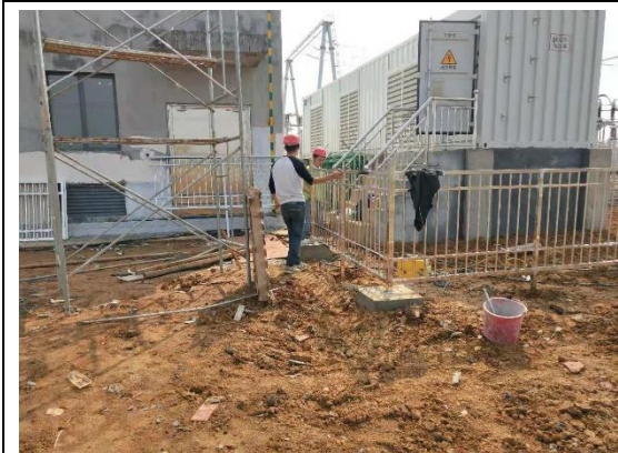
升压站设备区围栏安装
