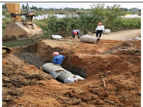
升压站排水管敷设
