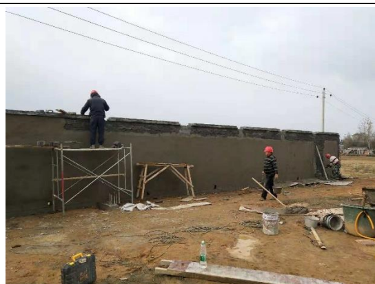
升压站西侧围墙抹灰施工
