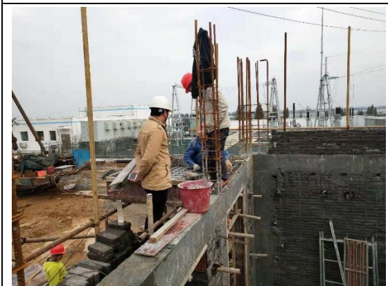
水泵房雨棚整改施工
