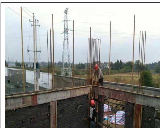
圈梁、柱钢筋支模、加固
