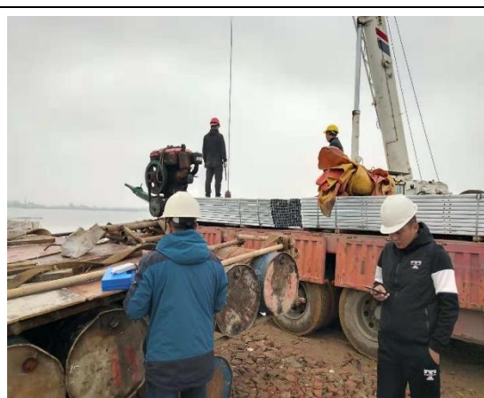
光伏区支架材料到货检查
