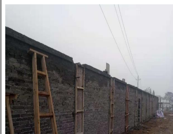
西侧围墙构造柱浇筑完成
