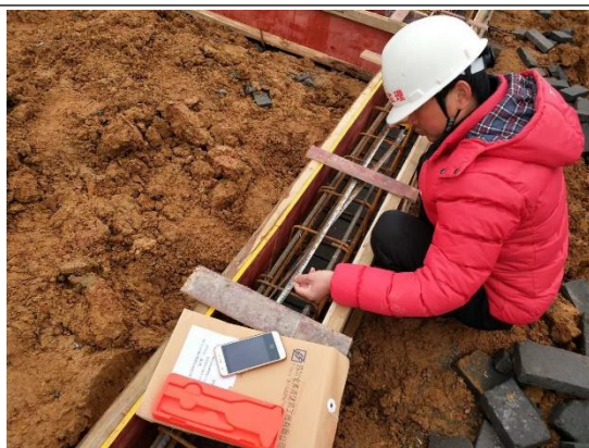
办公楼圈梁钢筋检查
