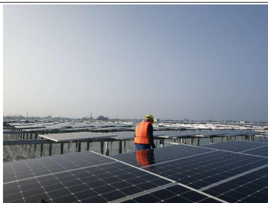
光伏区组件安装
