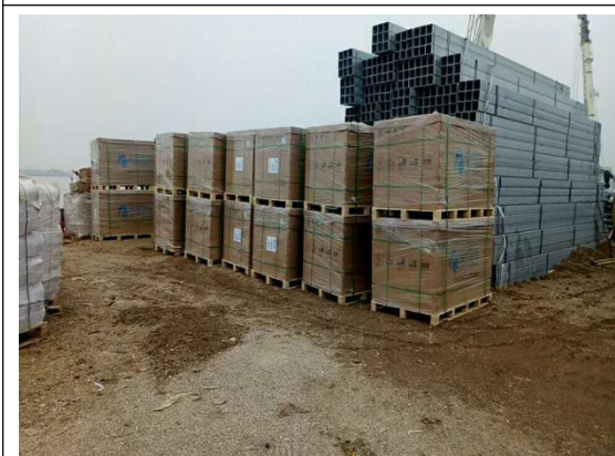
光伏区组件 14 号开始进场
