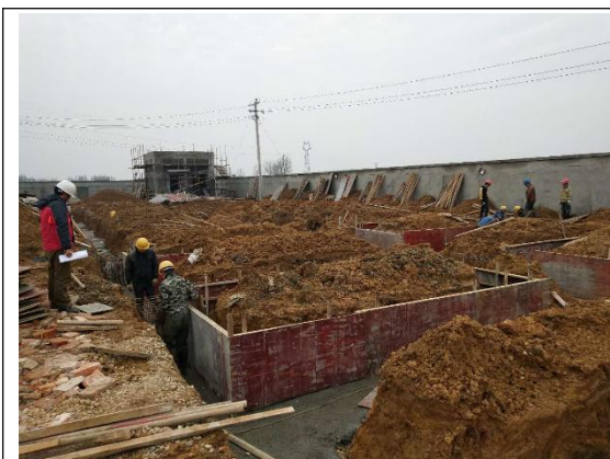
综合楼基础支模施工
