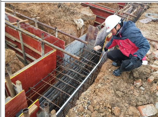
检查综合楼基础钢筋绑扎
