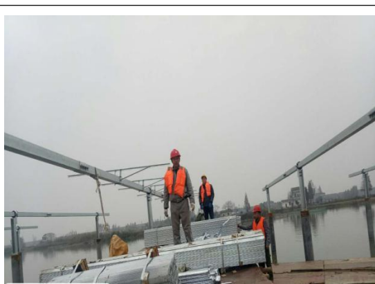
光伏区支架安装
