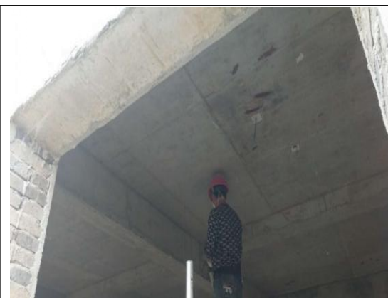
综合楼天棚打磨
