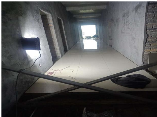
综合楼地砖施工
