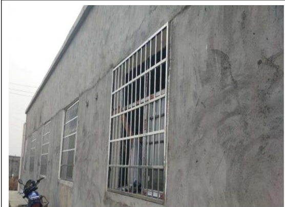
综合楼门窗防盗安装
