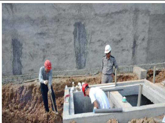
升压站污水处池设备安装
