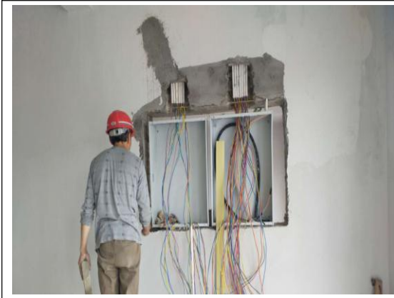
升压站办公楼门厅配电柜安装
