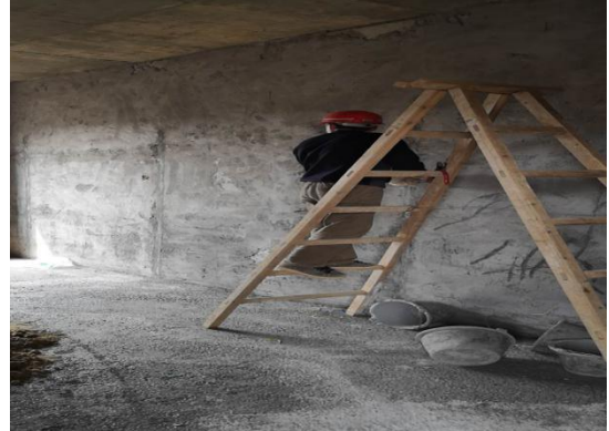
综合楼电线电缆安装
