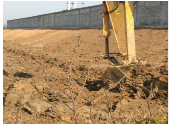
升压站围墙护坡施工
