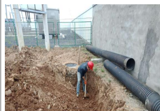
升压站污水池回填
