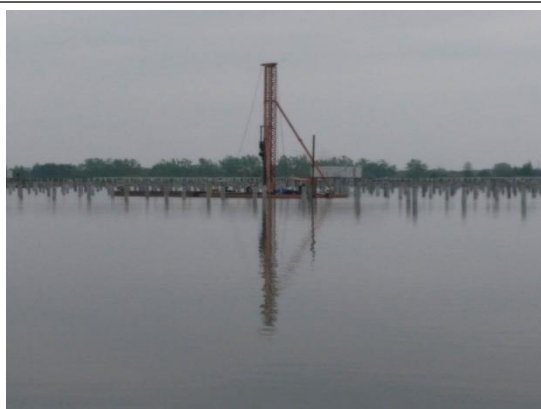
光伏区桩基施工
