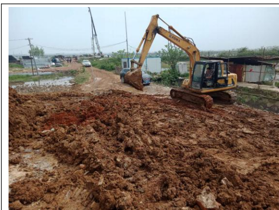
升压站场地平整
