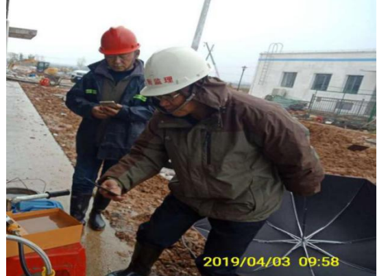
综合楼供水管试压
