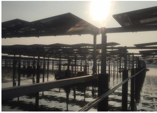
光伏区线缆安装
