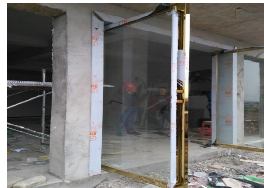
综合楼门窗安装
