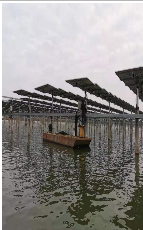
光伏区汇流箱更换
