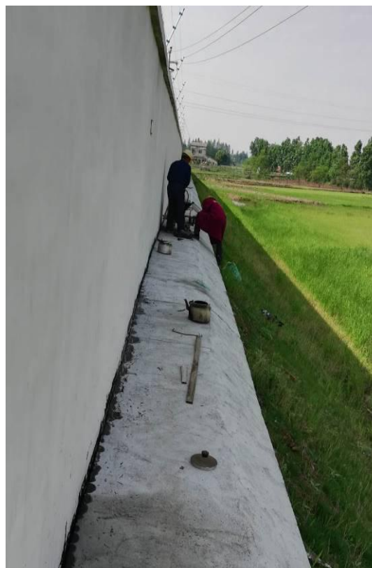
升压站围墙护坡整改
