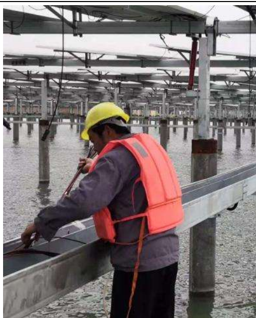
光伏区桥架安装
