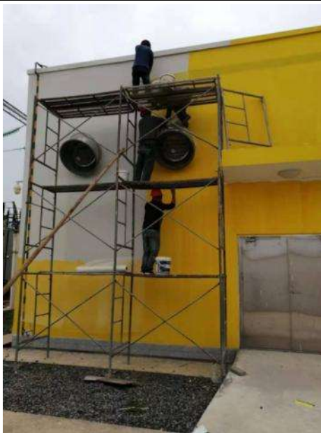
升压站综合楼外墙粉刷
