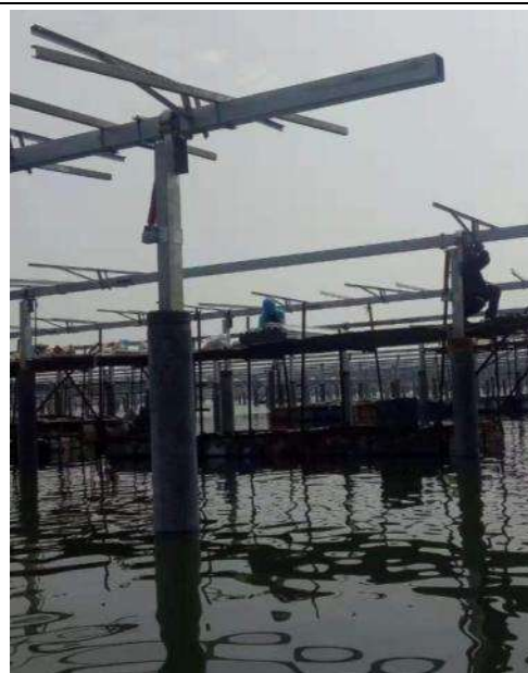
光伏区支架安装
