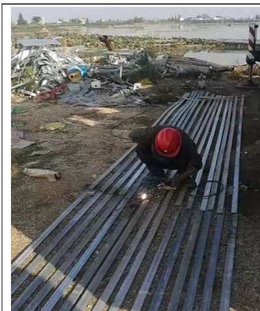
光伏区接地扁铁焊接
