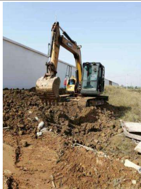
升压站排水沟开挖
