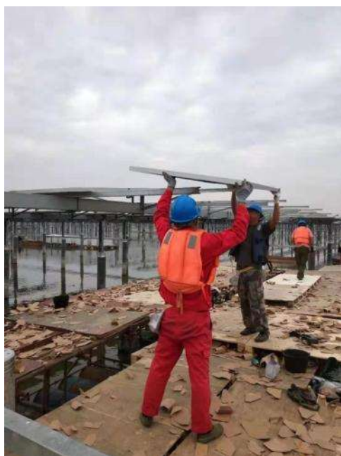
光伏区光伏组件安装
