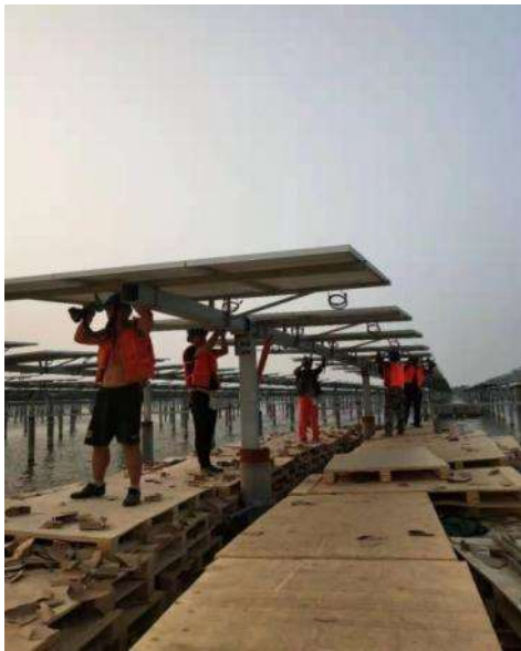
光伏区光伏组件安装
