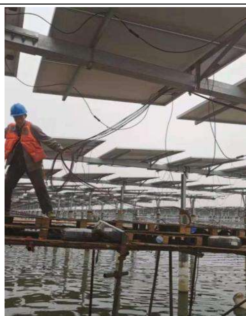
光伏区电缆敷设
