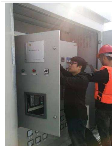
光伏区逆变器主板跟换
