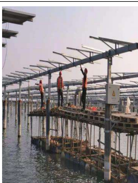
光伏区 1×4 光伏线敷设
