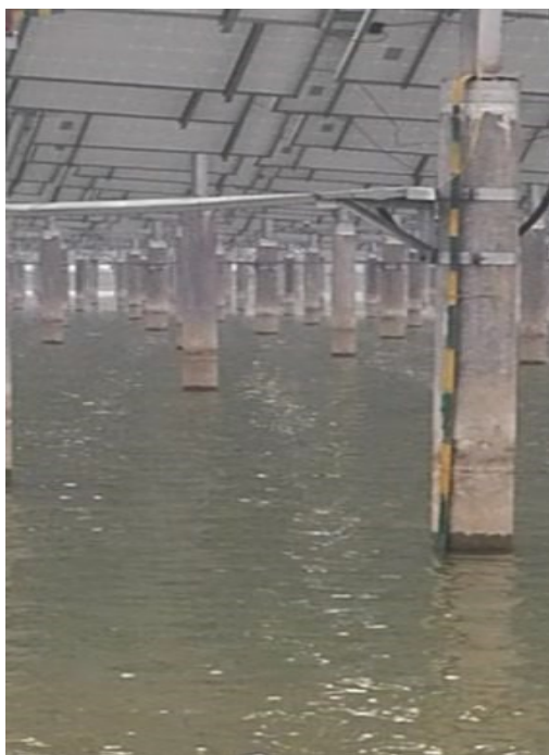
光伏区接地整改
