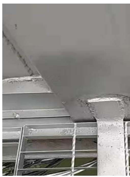
光伏区箱、逆变平台加固、防腐（消缺）
