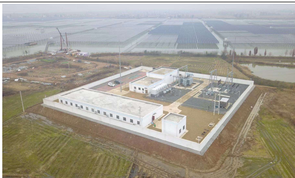
开关站完成情况（12月22日）
