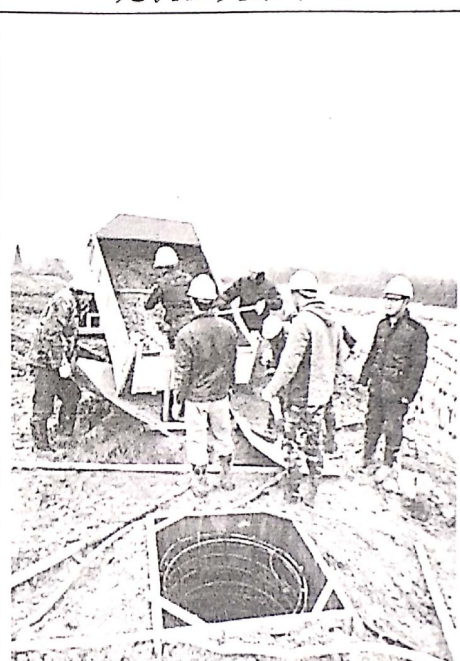
南琴线 7#塔基基础浇筑监理人员旁站
