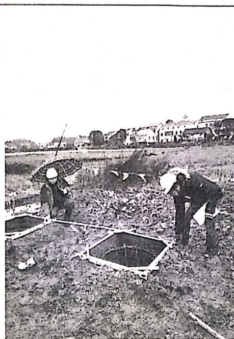
监理人员外线施工情况检查
