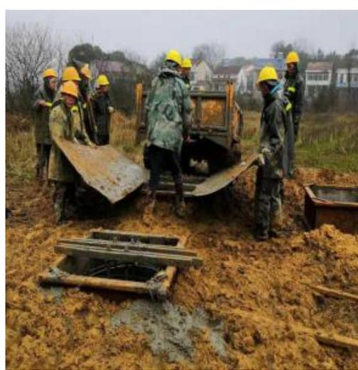
南琴线 22 号塔基浇筑混凝土
