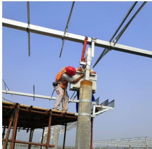
现场汇流箱安装
