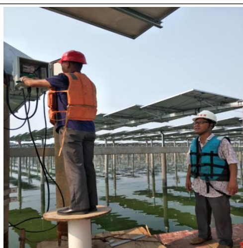
对光伏区驱动机调试进行检查
