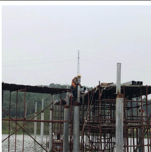
现场支架安装、组件吊运施工
