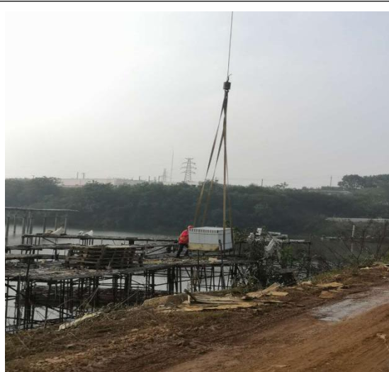
现场支架安装、组件吊运施工
