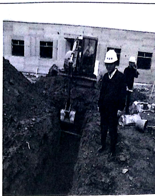
监理人员巡视检查
