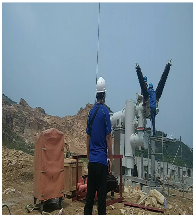
升压站 GIS 组装
