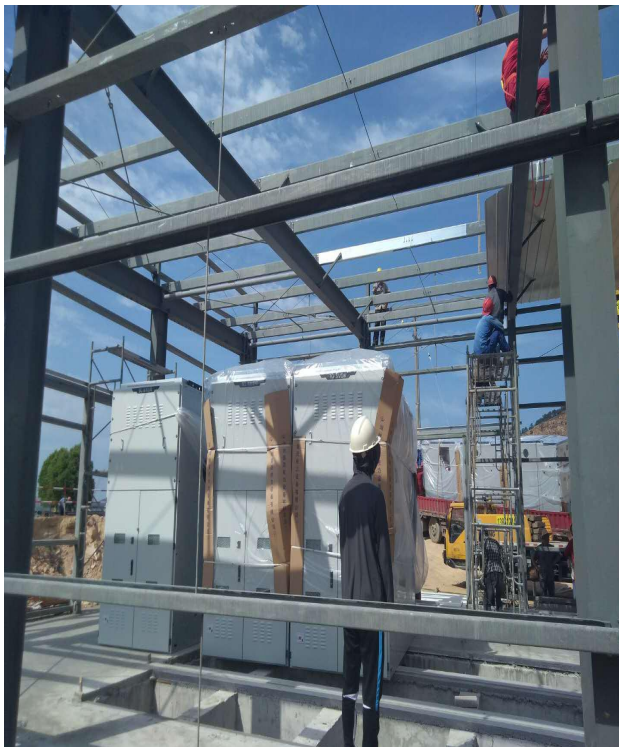
主控楼屋顶安装
