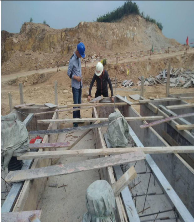
升压站接地变基础检查
