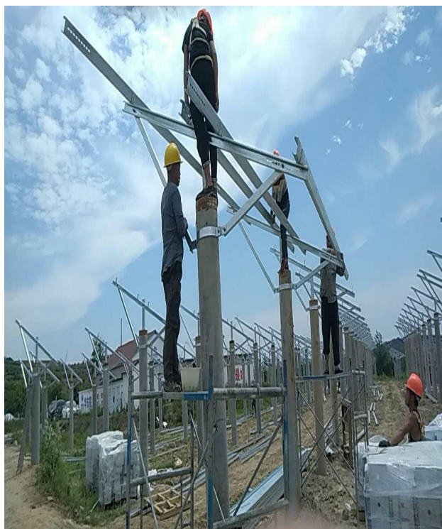
光伏区支架安装
