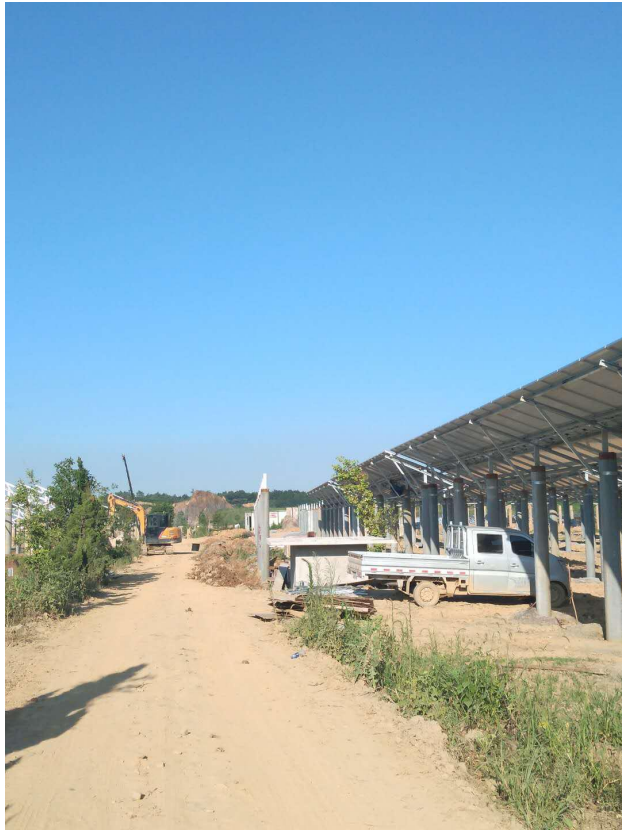
升压站设备检查
