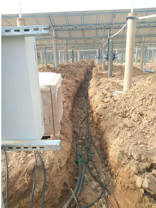
光伏区逆变器组装
