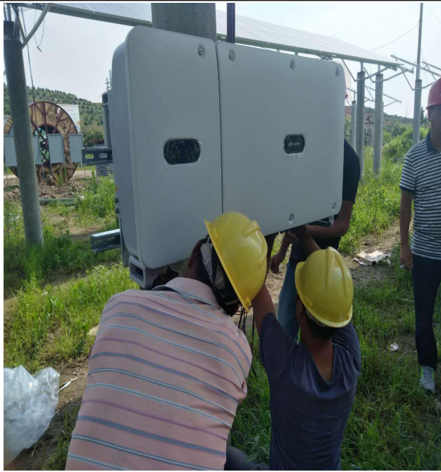
光伏区逆变器组装
