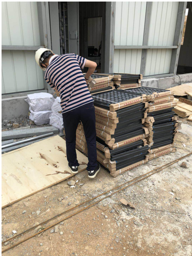
升压站设备到货检查
