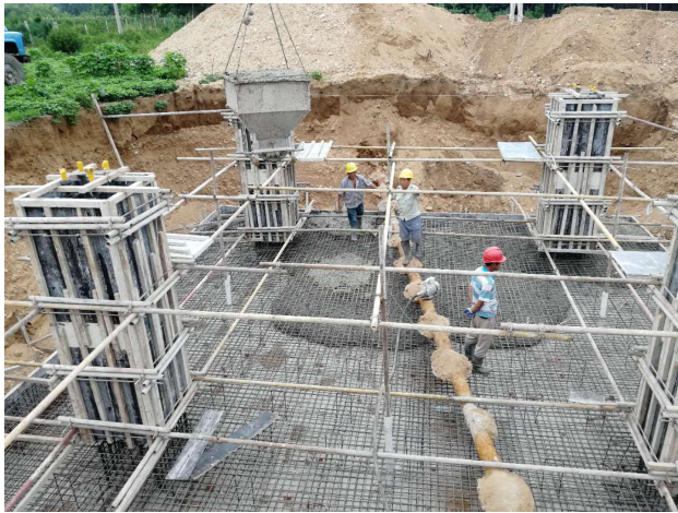
外线 26 号塔基 浇筑
