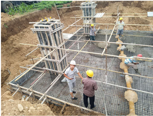
检查外线 26 号钢筋及模板安装
