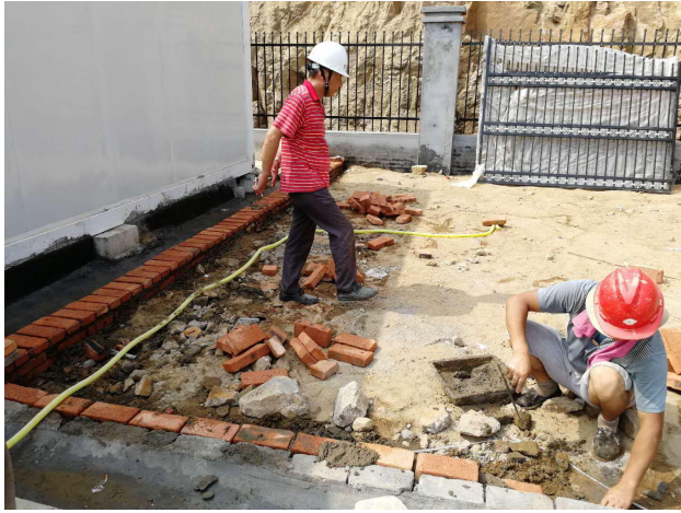
检查开关站排水沟砌筑情况
