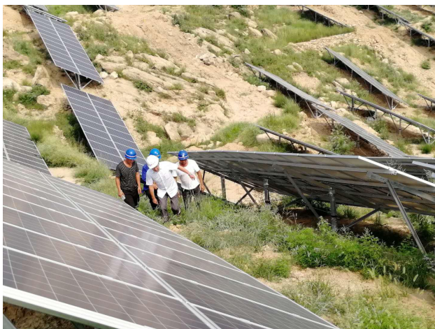
验收支架组件安装
