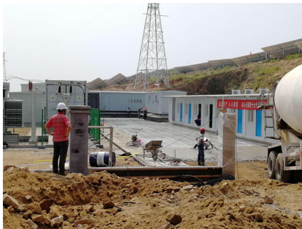
旁站开关站路 面硬化
