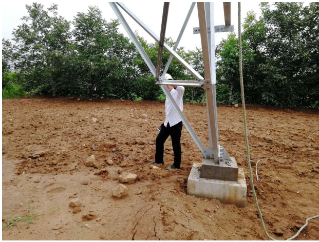
检查 13 号塔螺 栓紧固情况
