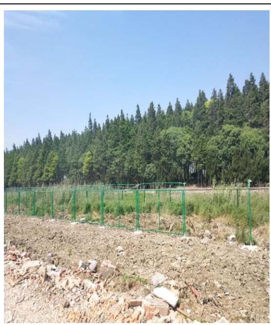
场区围栏安装
