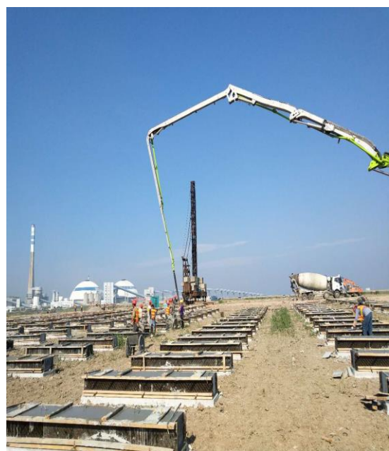
条形基础浇筑
