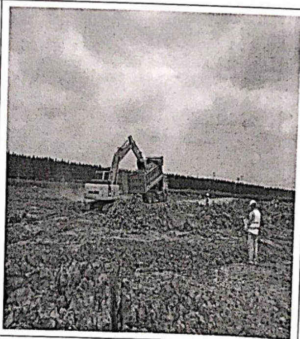
东区建筑垃圾铺路
