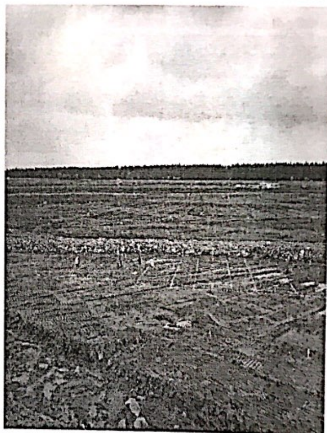
东区定位放线
