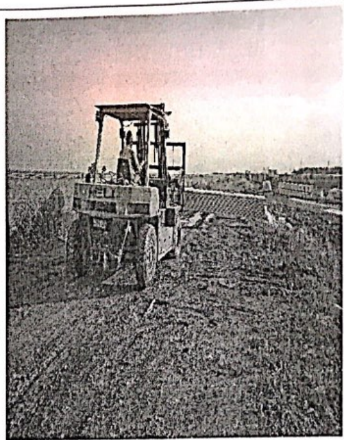
东区支架檩条倒运
