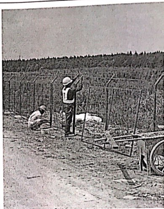
东区围栏安装
