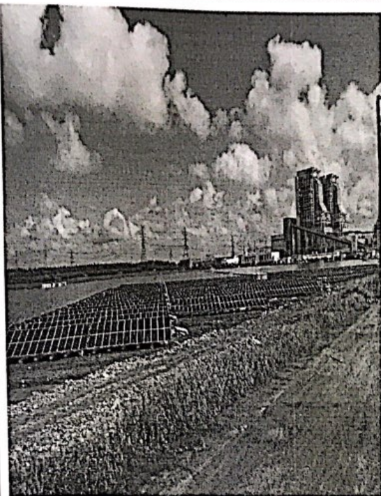
东区叠瓦组件安装完成
