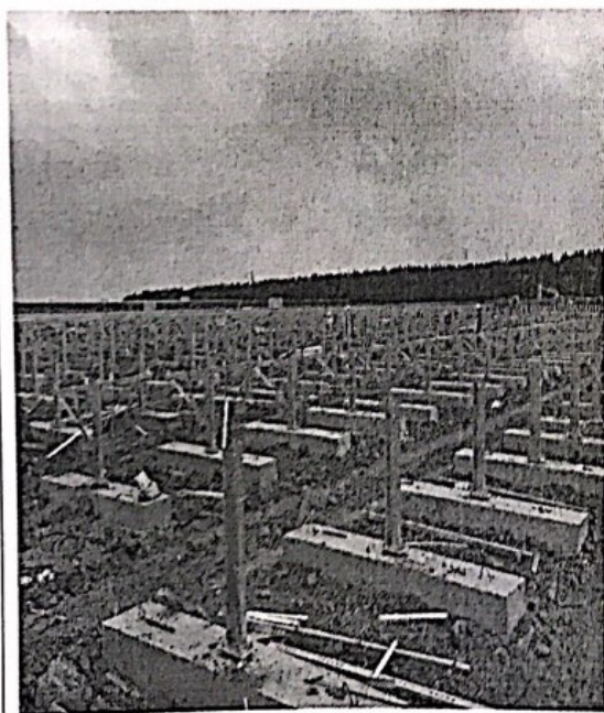
东区可调支架安装
