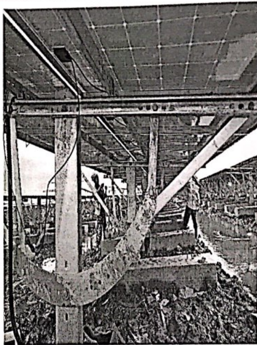
可调支架拉杆安装
