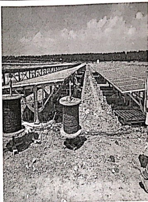
东区光伏电缆敷设
