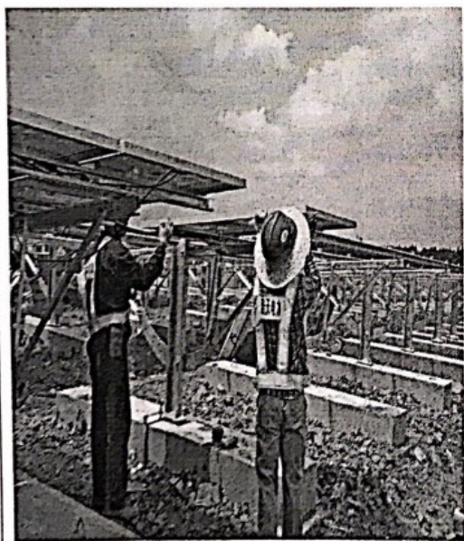
东区直流电缆敷设
