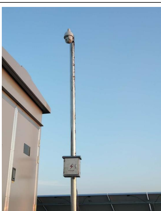
场区视频监控安装
