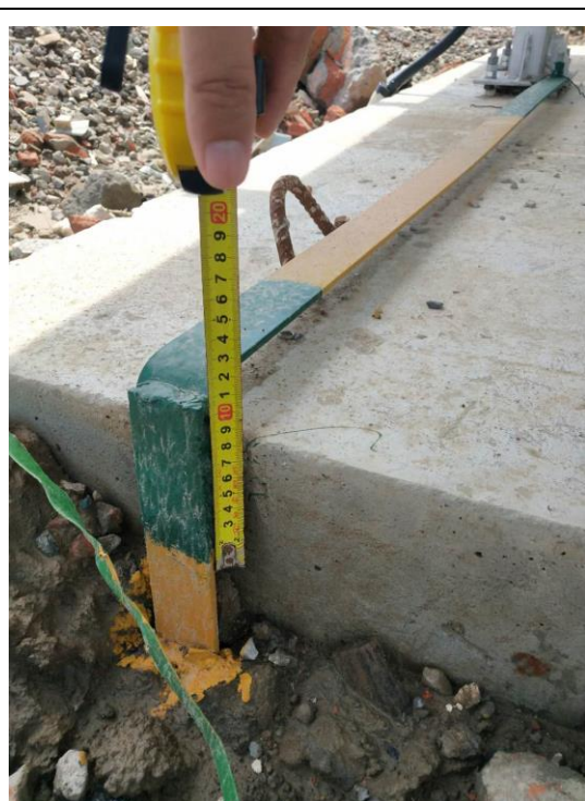
现场检查接地扁铁焊接情况
