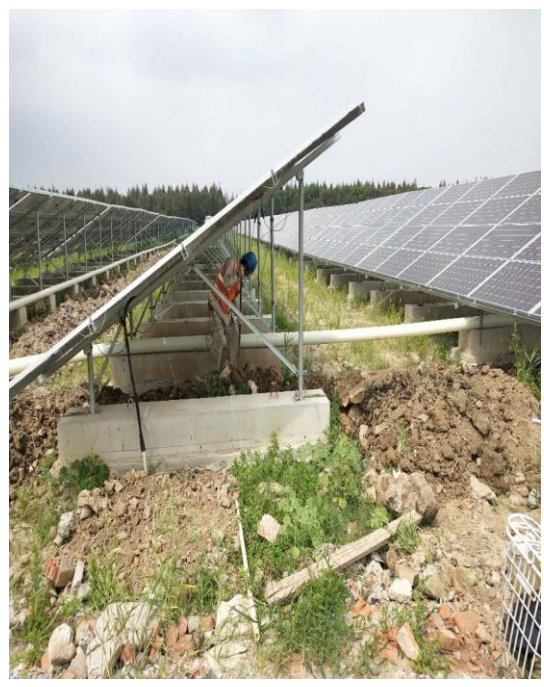
西区电缆穿管埋管整改
