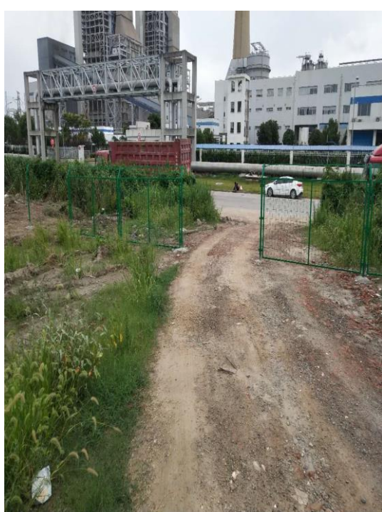
场区围栏安装
