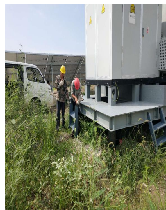
场区箱变平台台阶安装
