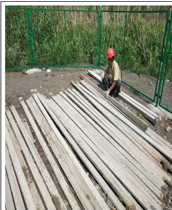
场区模板清理
