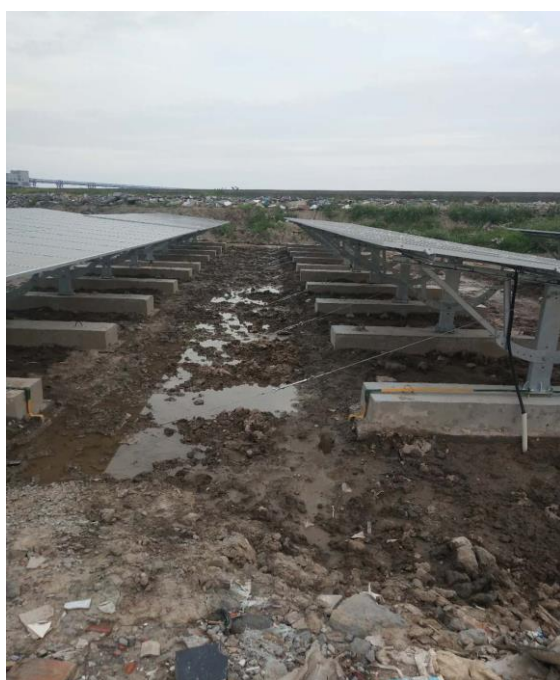
东区拉线盘试装完成
