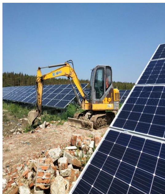
西区电缆埋地整改
