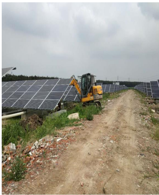
西区电缆埋地整改
