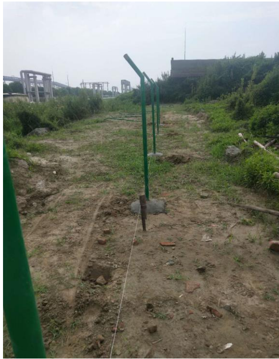
场区围栏安装
