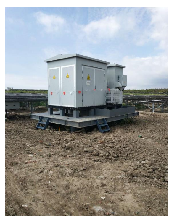
场区箱变平台台阶安装完成
