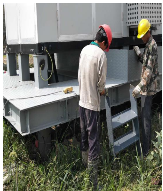
场区箱变平台台阶安装
