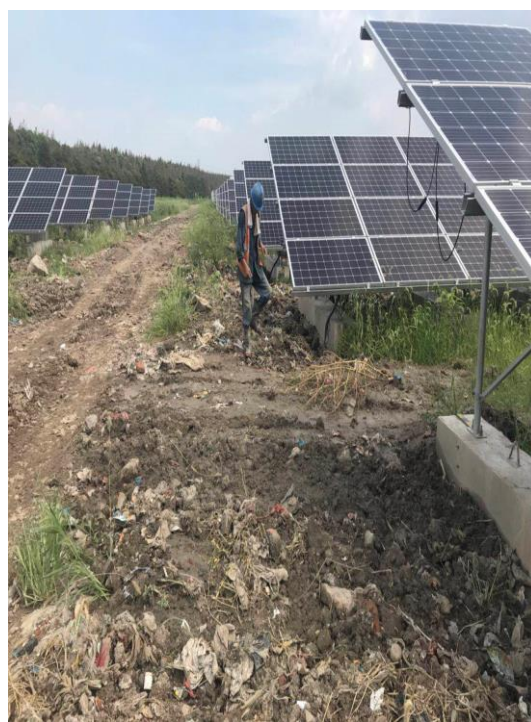
西区光伏线缆绑扎
