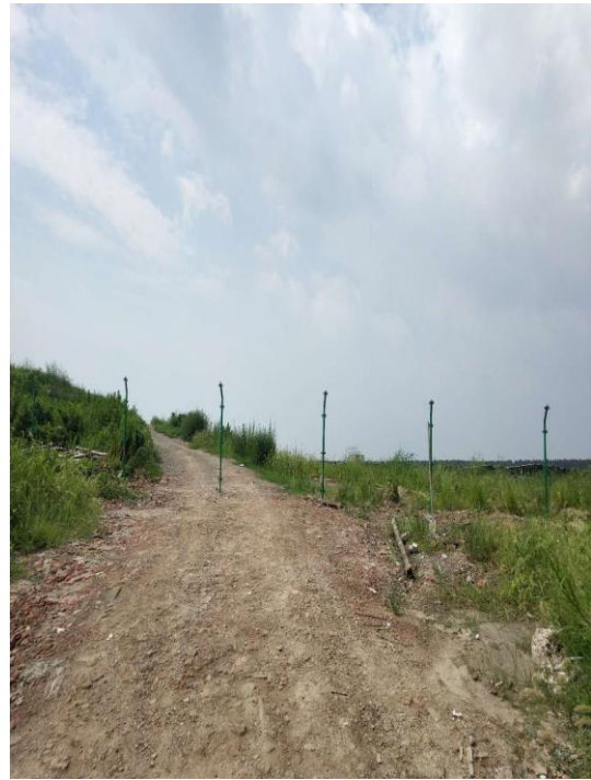
场区围栏安装
