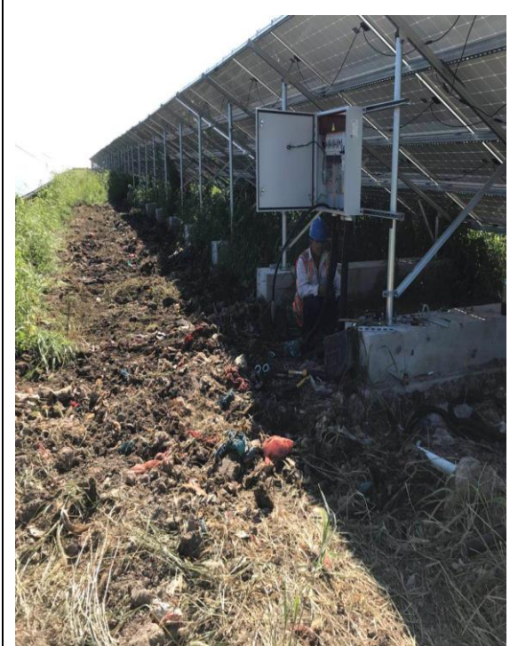
西区汇流箱接线整改
