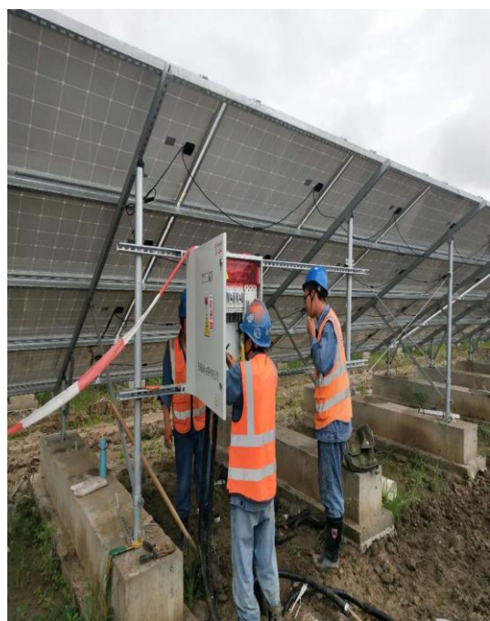
西区电缆穿管整改
