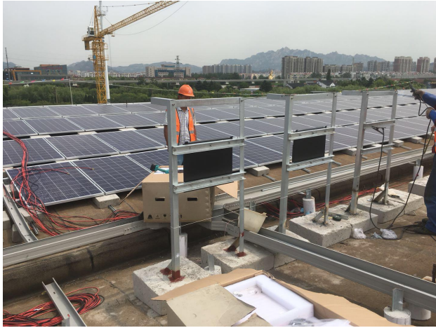
逆变器支架安 装
