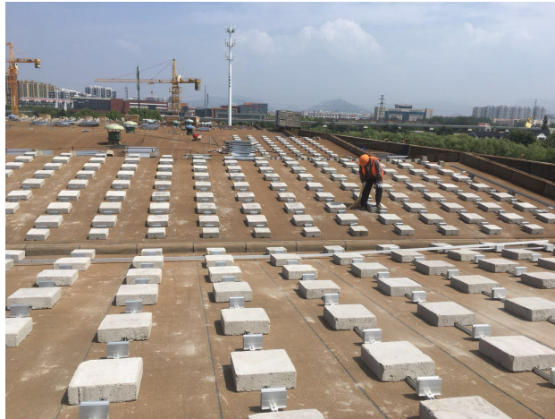
压载安装 导轨安装 组件安装
