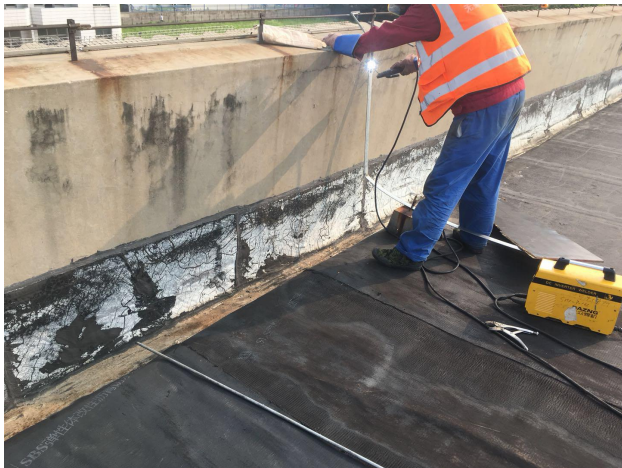
接地扁钢焊接
