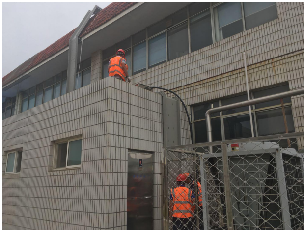
下墙桥架安装
