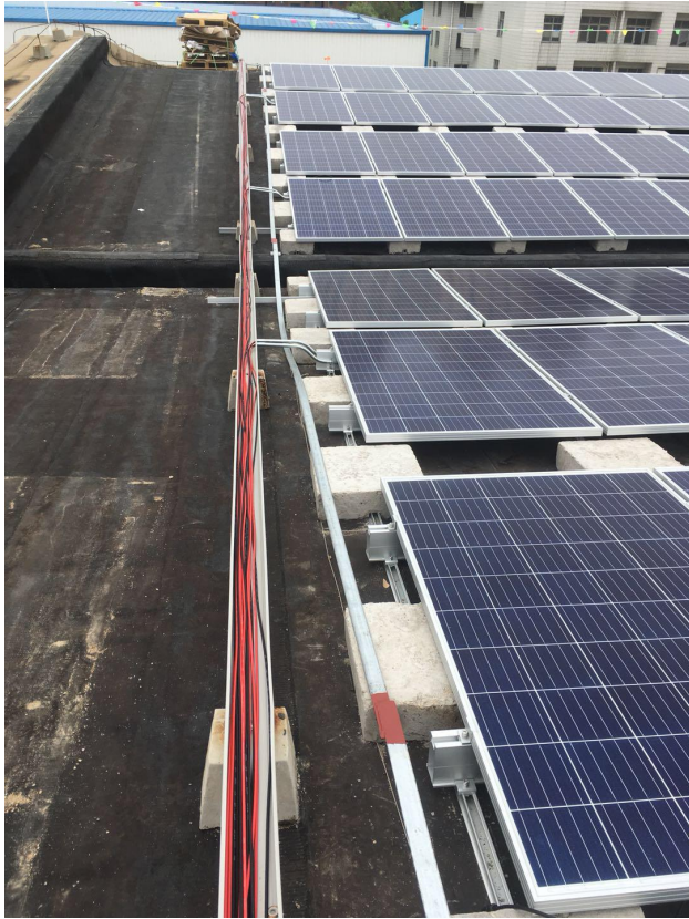
直流电缆敷设
