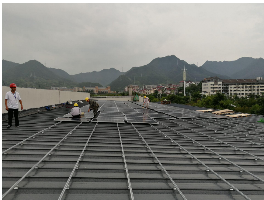
9 号屋面车棚组件安装
