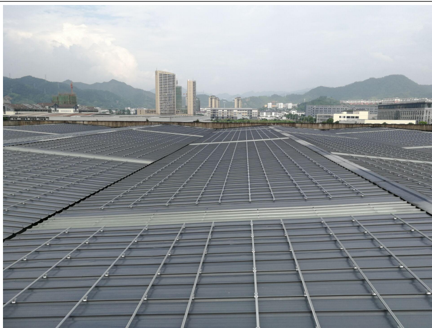
9 号车间屋面导轨安装
