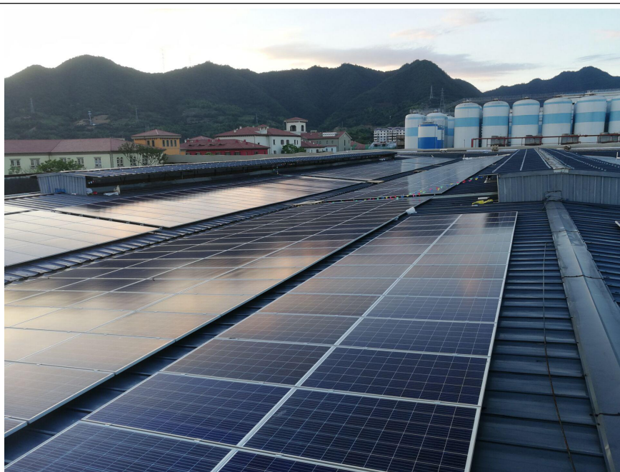
灌装车间三组件安装
