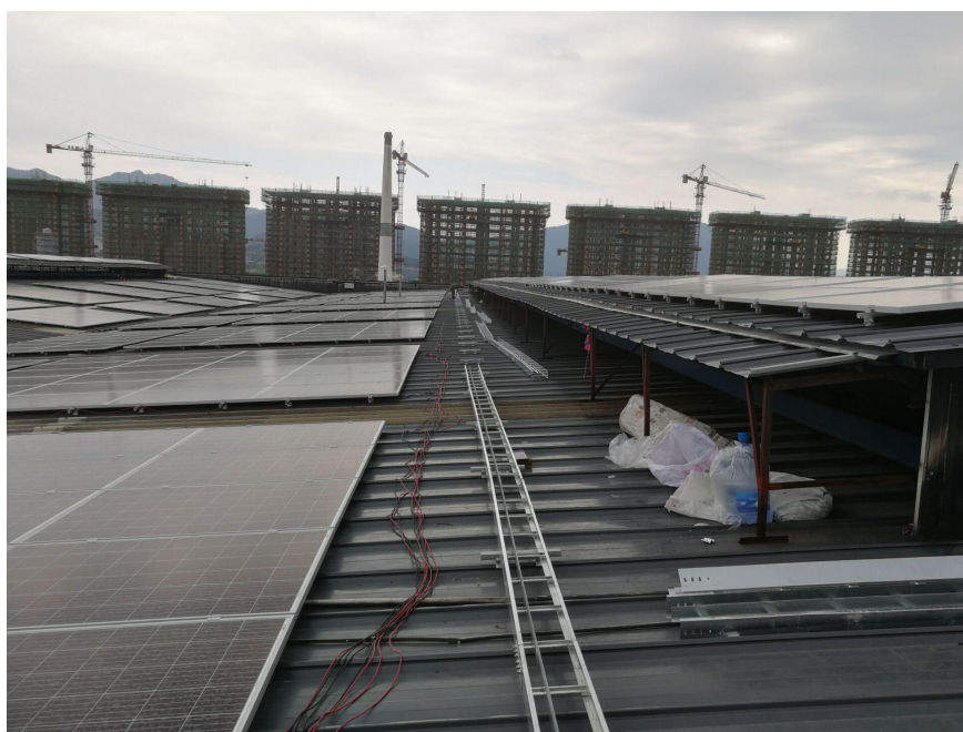
灌装车间桥架安装
