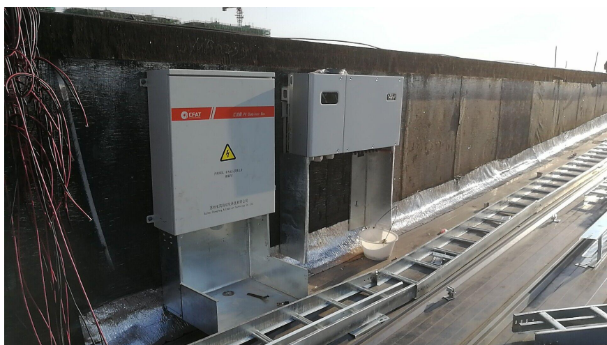
逆变器、汇流箱安装
