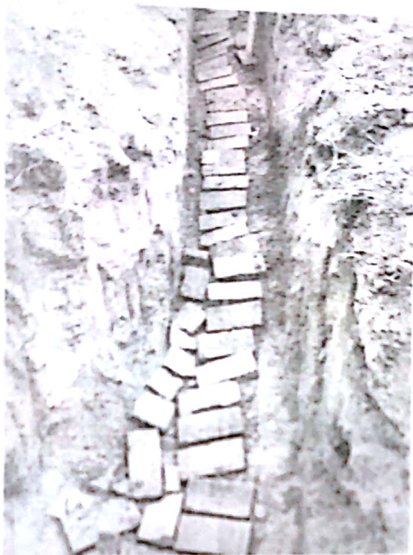
43 区直流电缆沟验收
