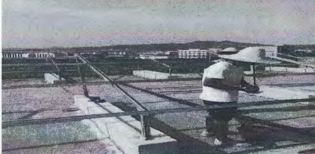
瑞金市“十二五”贫困村光伏扶贫扩面工程 瑞谷科技厂房屋顶电缆敷设20180812
