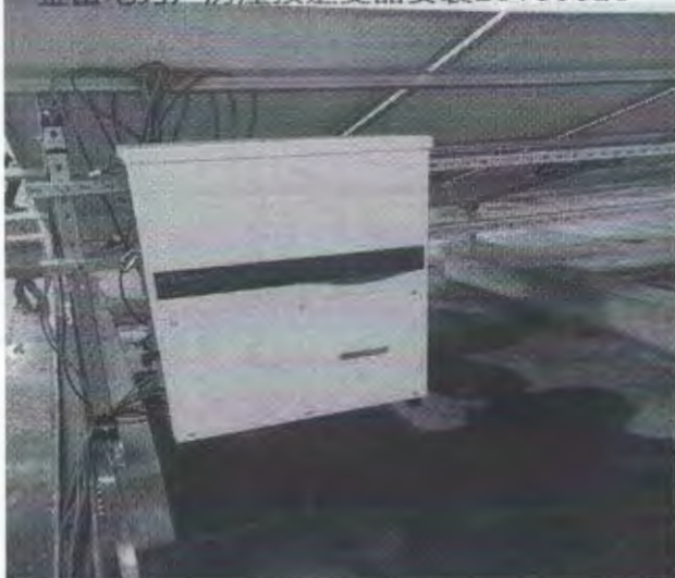
瑞金市“十二五”贫困村光伏扶贫扩面工程 金富电力厂房屋顶逆变器安装20180828
