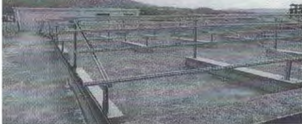
瑞金市“十二五”贫困村光伏扶贫扩面工程 厂房屋顶直流电缆敷设20180817
