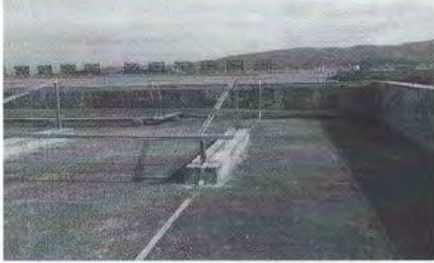
瑞金市“十二五”贫困村光伏扶贫扩面工程 厂房屋顶接地焊接施工20180809
