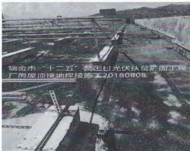
瑞金市“十二五”贫困村光伏扶贫扩面工程 厂房屋顶电站接地施工20180807
