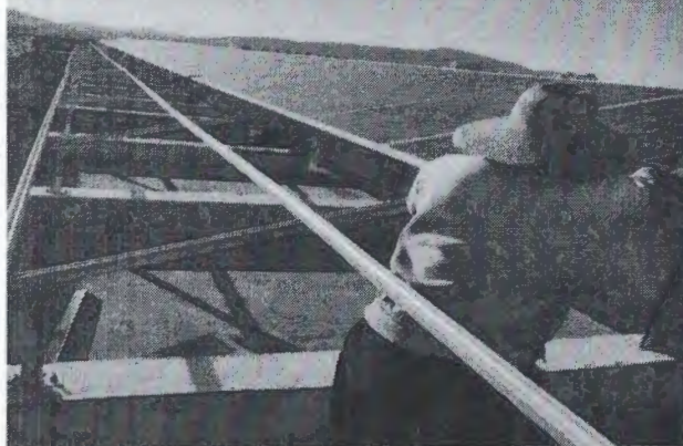
瑞金市“十二五”贫困村光伏扶贫扩面工程 红都兴厂房屋顶光伏组件安装20181030
