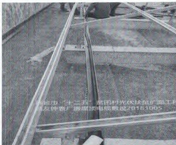
瑞金市“十二五”贫困村光伏扶贫扩面工程 希艺欧厂房屋顶光伏支架安装20181006
