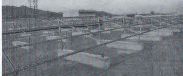
瑞金市“十二五”贫困村光伏扶贫扩面工程 希艺欧厂房屋顶光伏支架安装20181006
