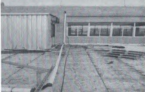
瑞金市“十二五”贫困村光伏扶贫扩面工程 乐群塑胶厂房屋顶电缆敷设20181023
