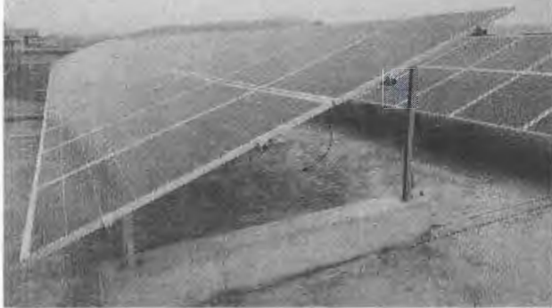
瑞金市“十二五”贫困村光伏扶贫扩面工程 红都兴厂房屋顶光伏组件20181116
