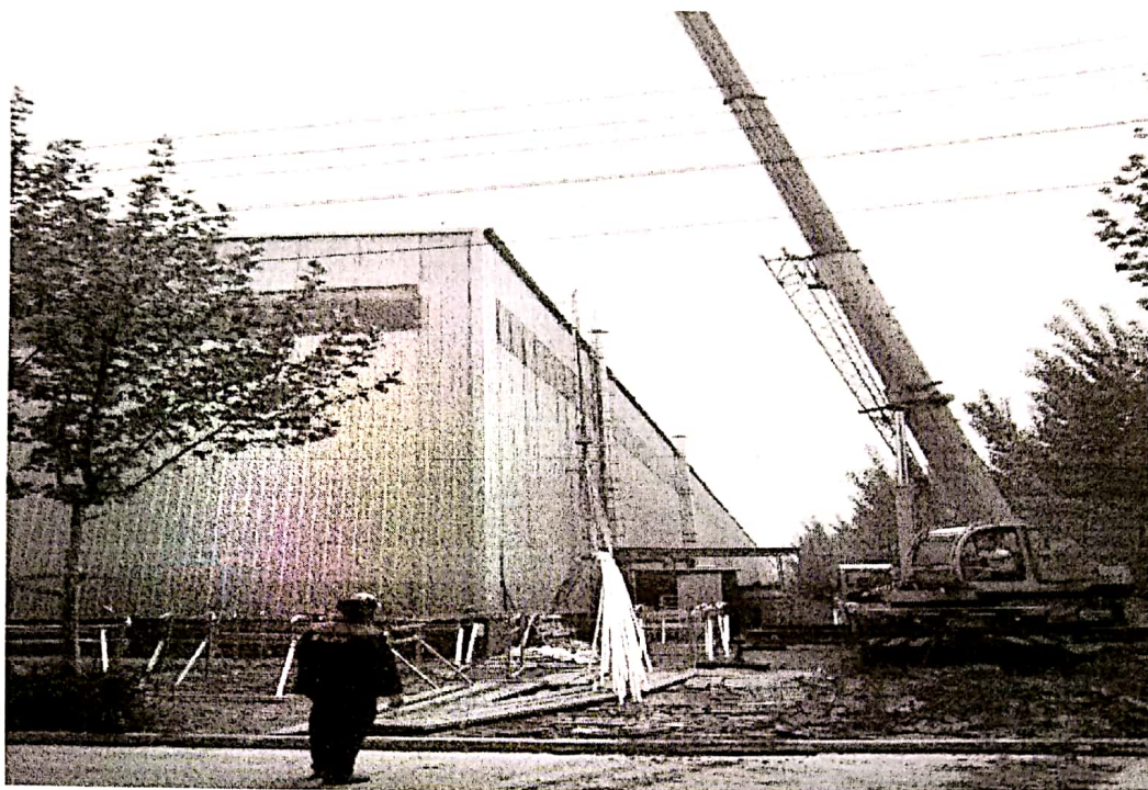
10号屋面镀锌接地扁铁吊运
