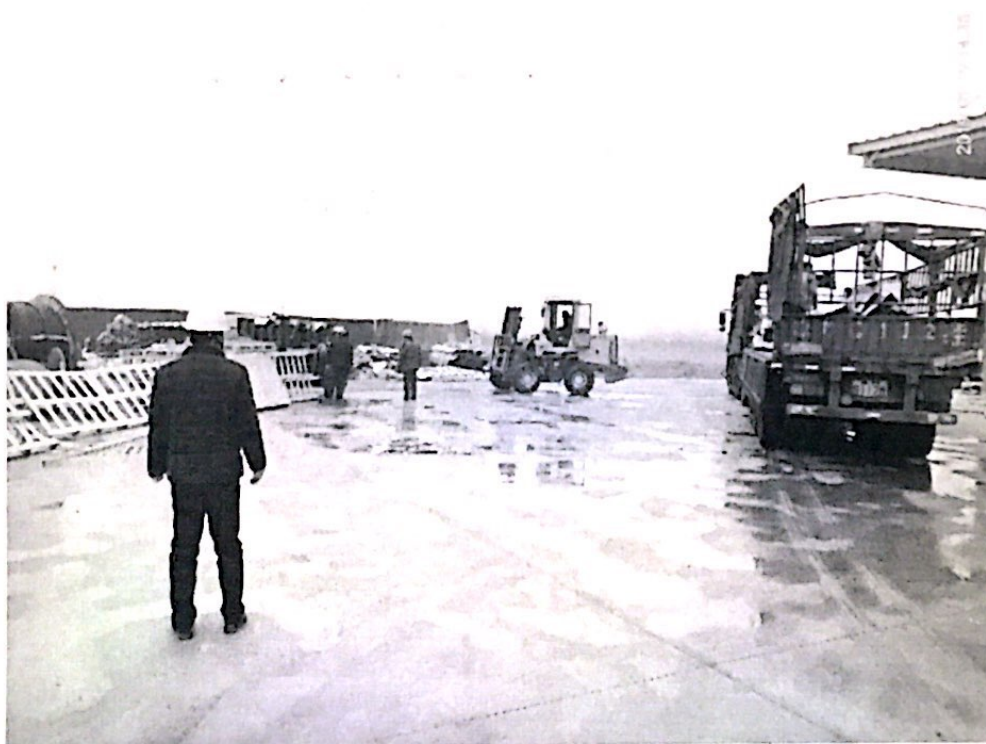
正泰公司其它已并网项目剩余材料、设备转运本项目监理现场检查验收
