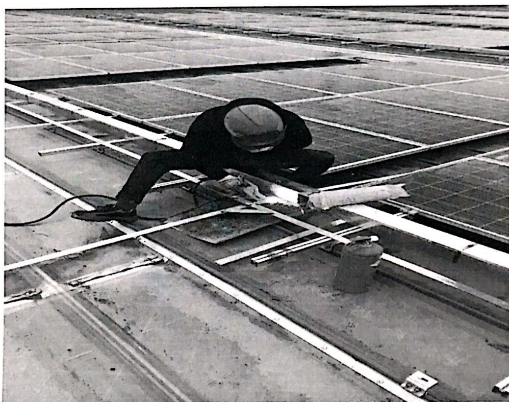
箱逆变器通讯电缆熔接
