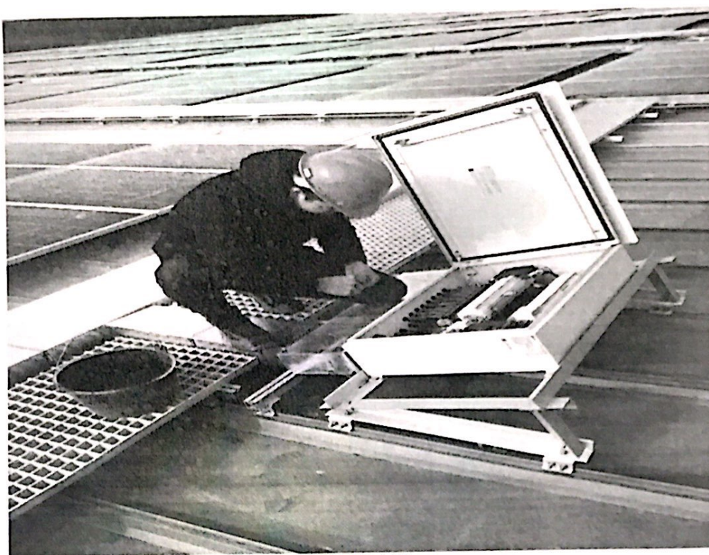
汇流箱设备内防火封堵制作
