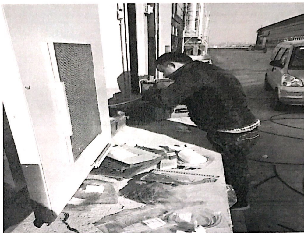
箱逆变器通讯电缆熔接
