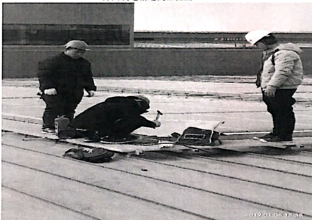
D号屋面镀锌扁铁焊接监理检查
