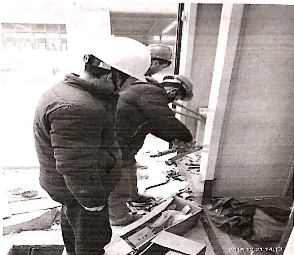
箱逆变设备电缆头制作监理旁站
