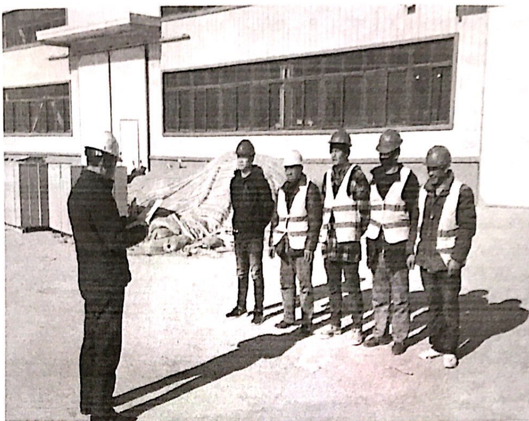
一二次预制舱吊装前监理进行对施工人员进行安全交底
