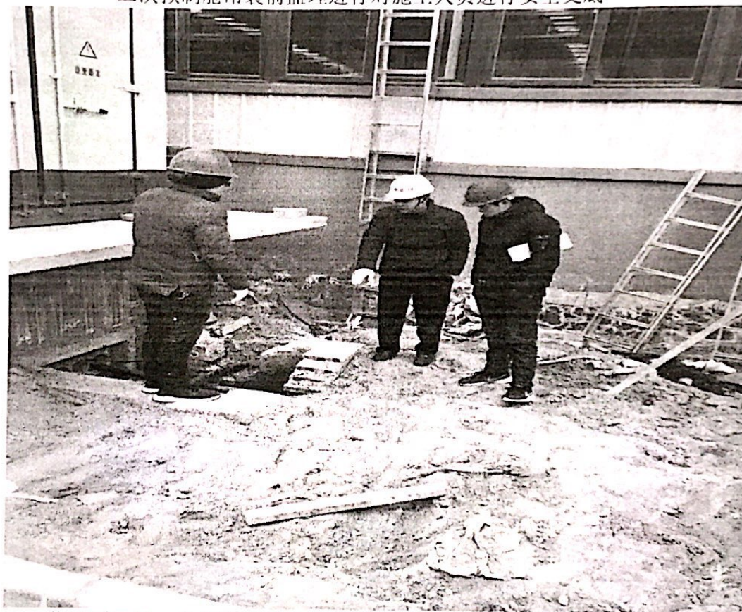
监理项目部、业主项目部、施工项目部负责人月度安全质量大检查
