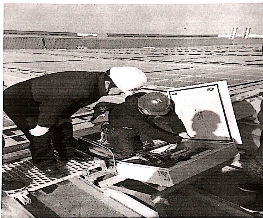
箱逆变设备电缆头制作监理旁站
