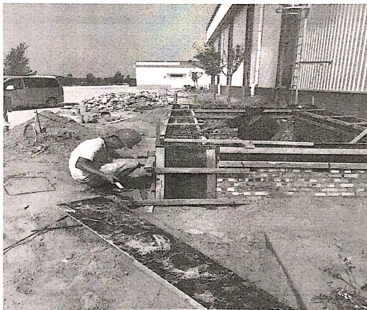
箱变基础模板安装
