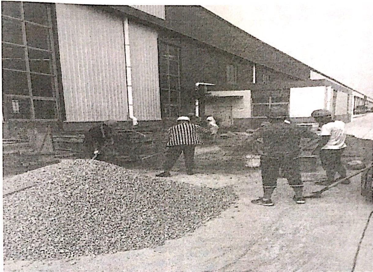
箱变基础圈梁混凝土浇筑（采用人工自拌，已留取样块后期送检）
