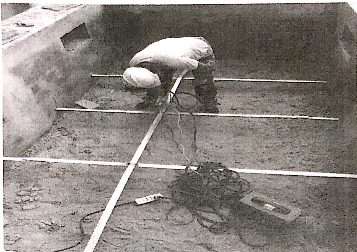
箱变基础内电缆支架加工
