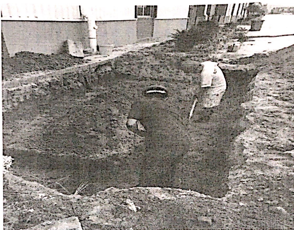
箱变基础人工土方开挖
