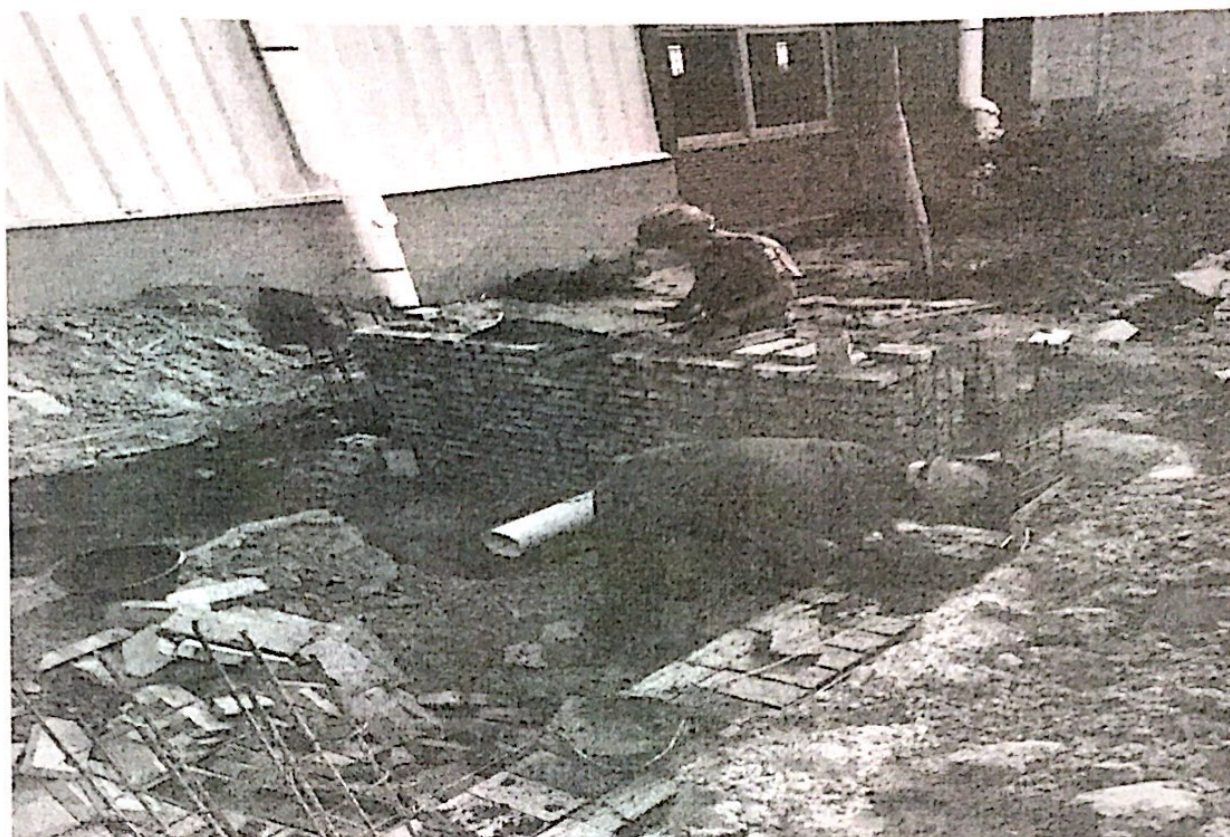
箱变基础墙体砌设
