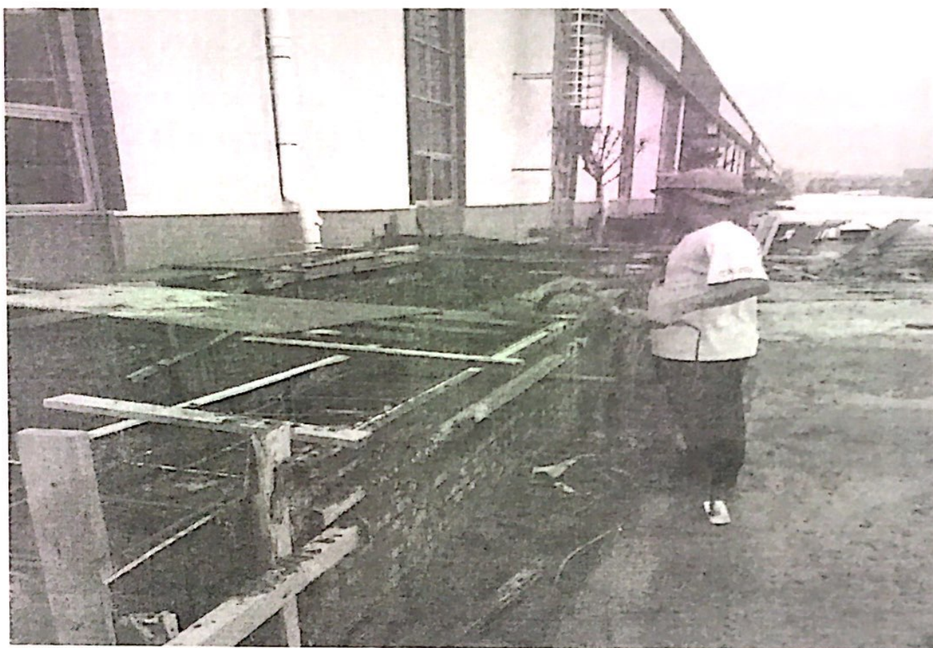
预制舱设备基础圈梁混凝土浇筑监理人员进行现场旁站
