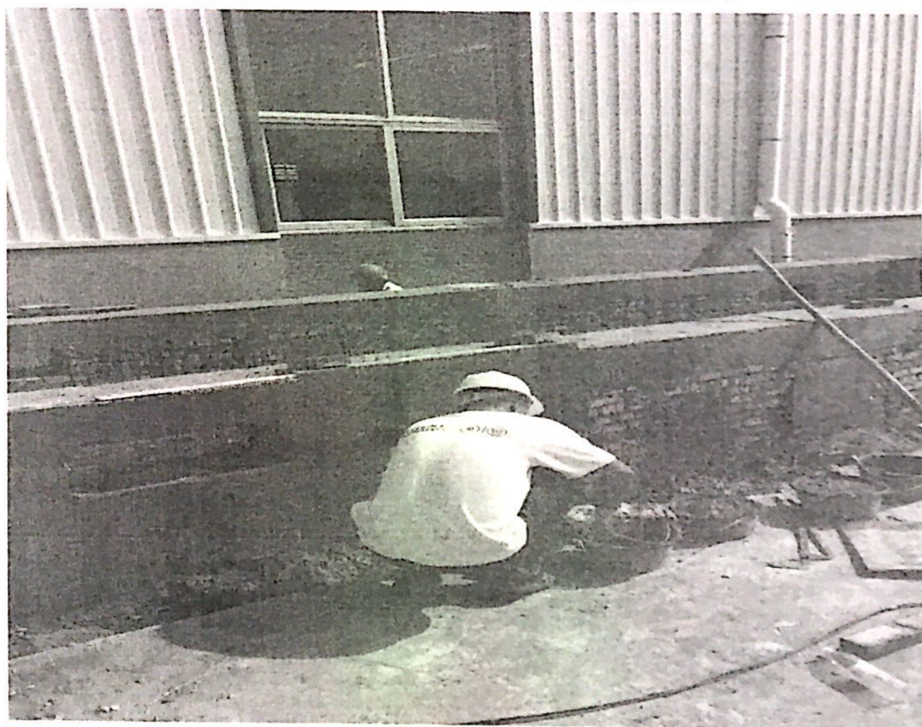
预制舱设备基础内外抹灰
