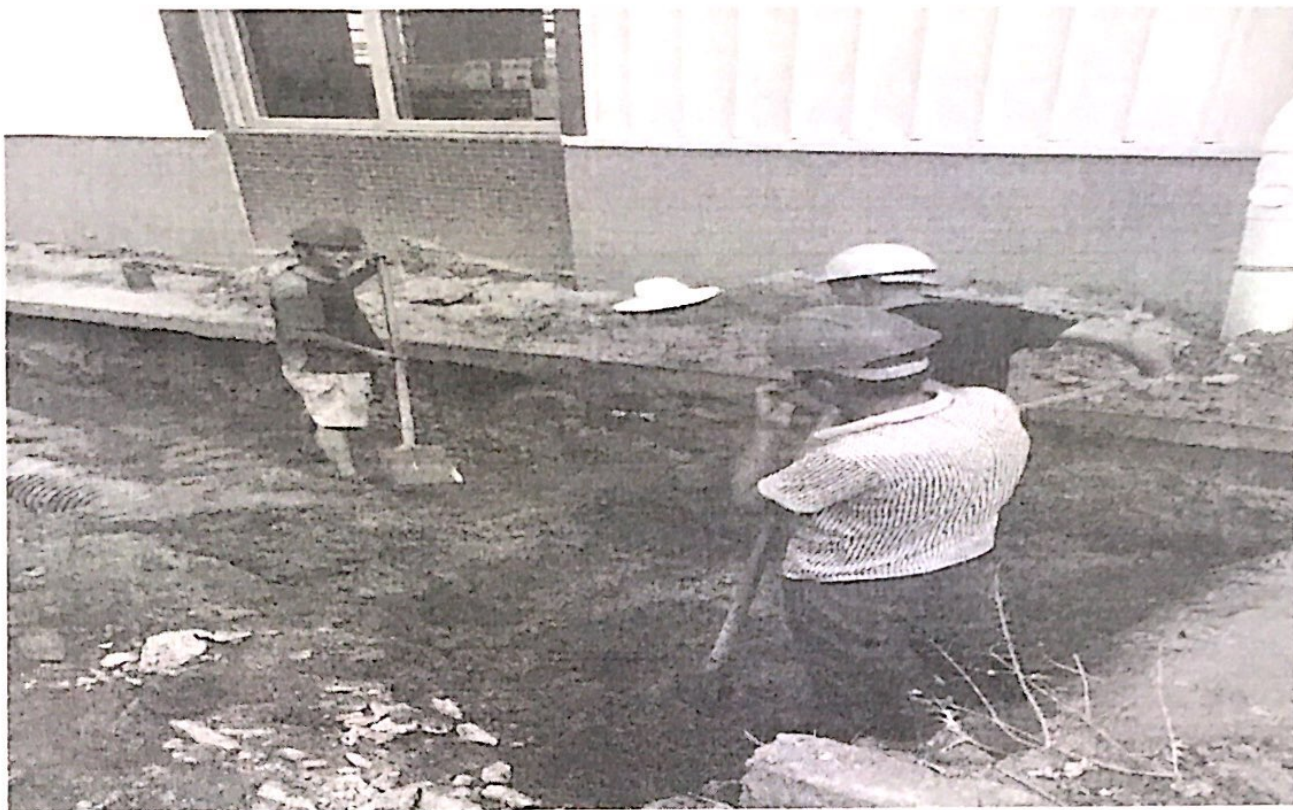
二次舱设备基础人工土方开挖
