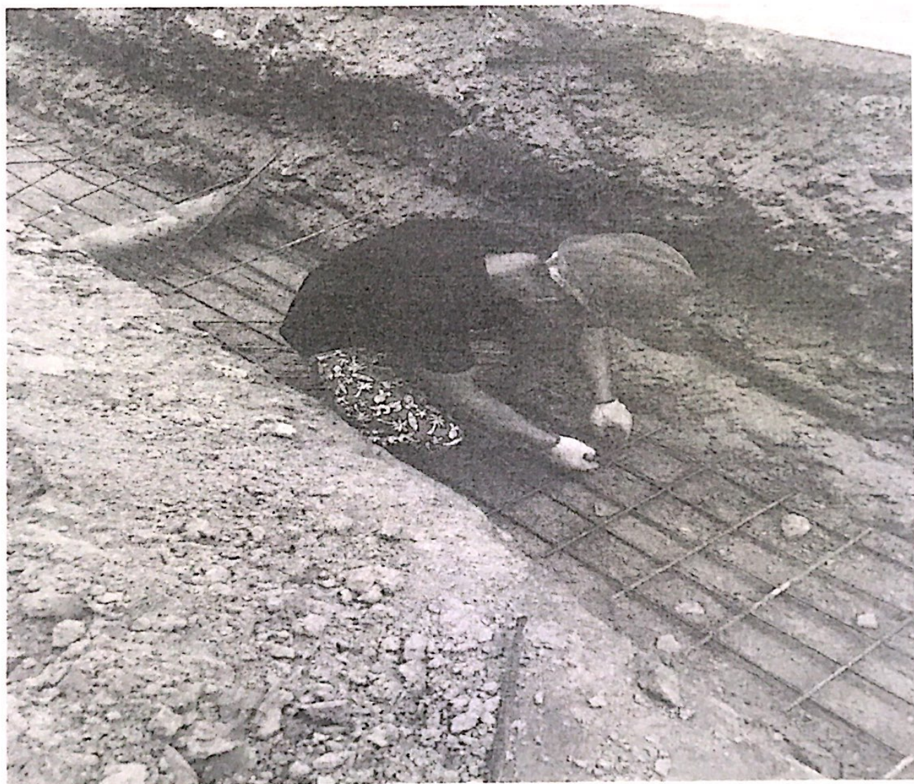
预制舱设备基础底部钢筋绑扎
