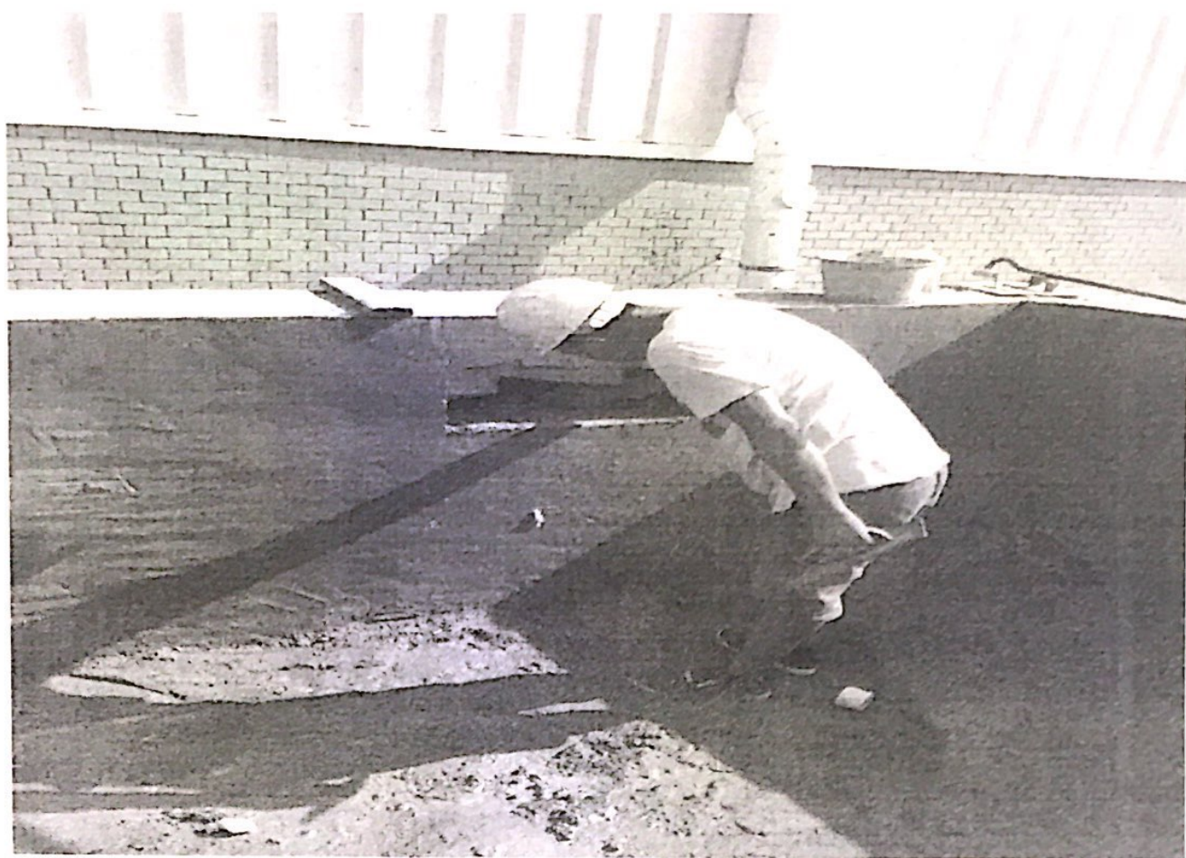
预制舱设备基础百叶窗安装
