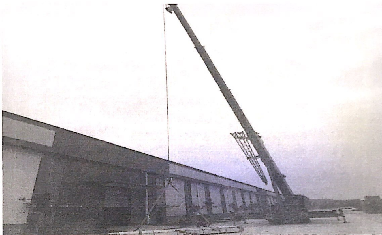
夹具、支架檩条吊运至 1#屋面光伏区，监理人员现场旁站
