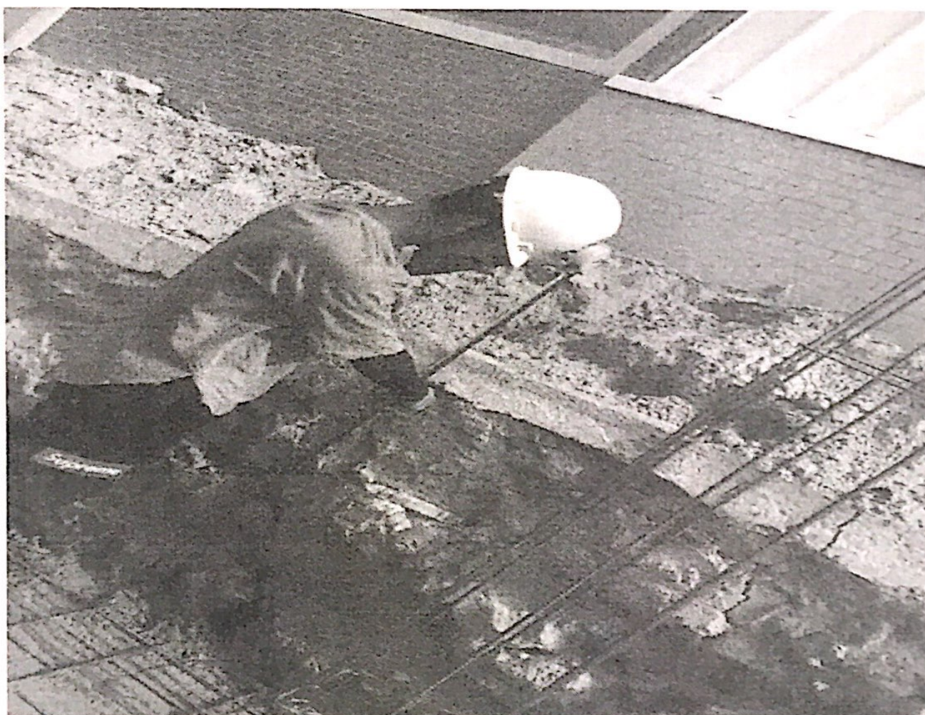
监理人员检查预制舱设备基础基坑是否符合图纸要求
