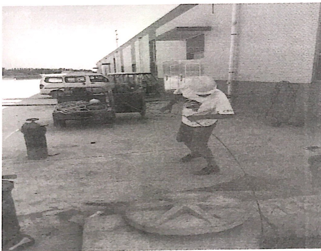
调度通讯电缆敷设
