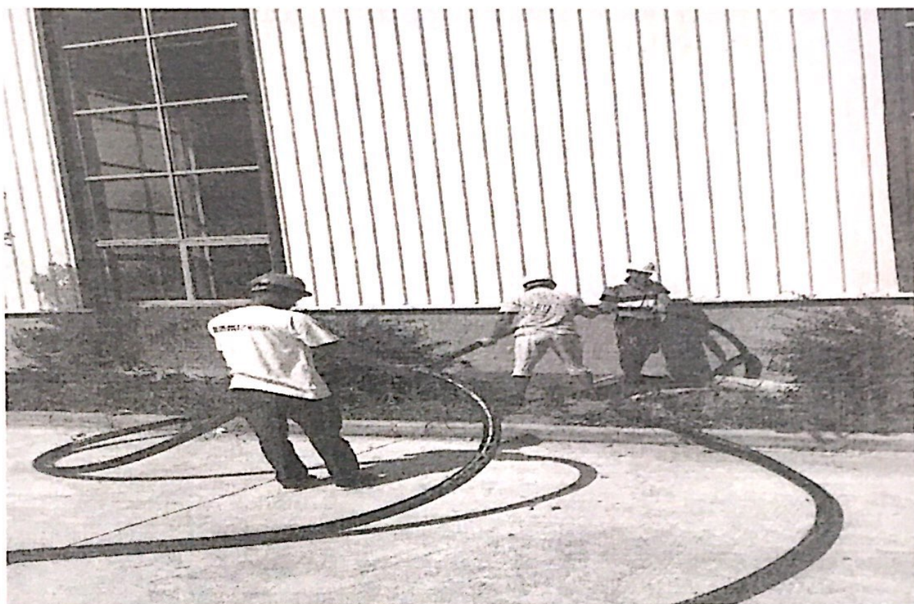
3*95 高压电缆敷设
