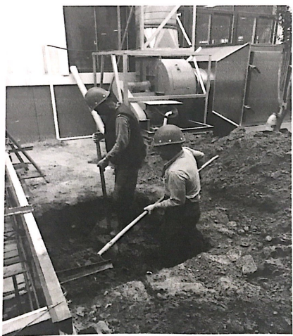
电缆井人工土方开挖
