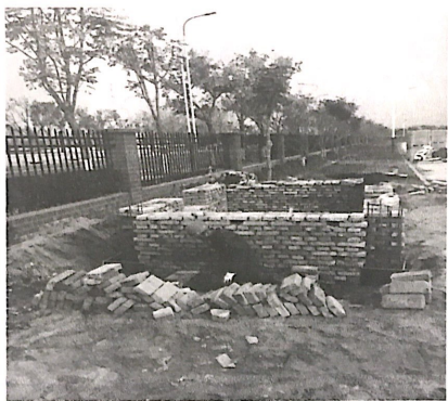
1#箱变基础墙体砌设
