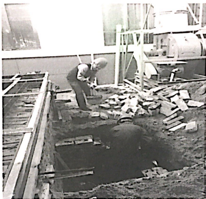
电缆井基础砌设
