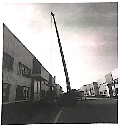
夹具吊运至屋面光伏区
