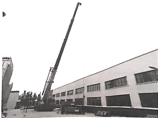
光伏组件吊运至屋面光伏区
