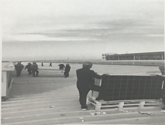
屋面光伏区光伏组件搬运摆放
