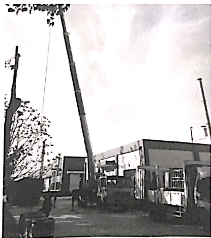
电缆进场吊运卸车
