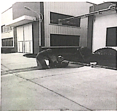
过路预埋管道切割
