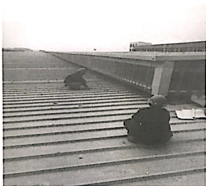
屋面光伏区放线定位
