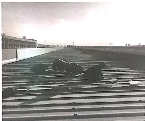
屋面光伏区支架安装
