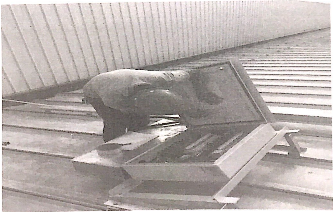
1#屋面汇流箱内侧出线图粘贴
