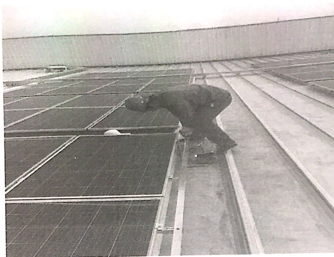
1#屋面镀锌接地扁铁固定
