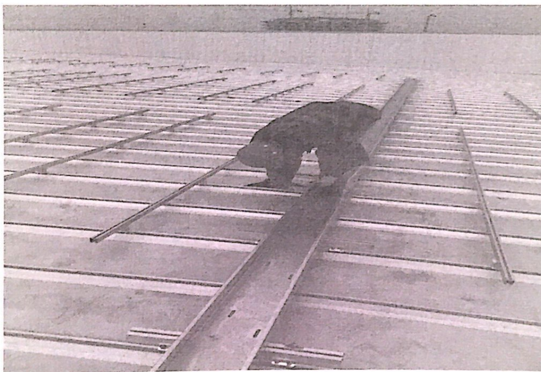
2#屋面电缆桥架安装
